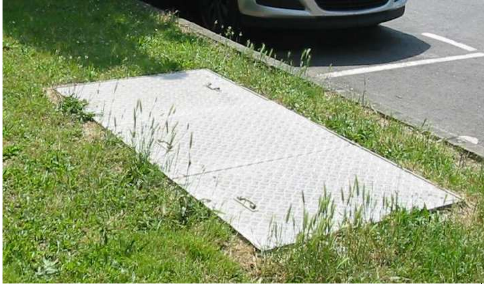
Détail des plaques de couverture de la niche de comptage
