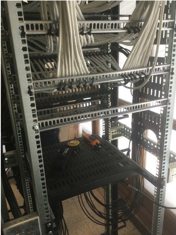
Baie avec 4 montants verticaux pour fixer les accessoires, supports de câblage...
