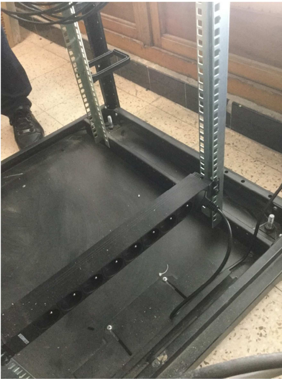
Bandeau de prises de courant en position basse arrière dans la baie qui est équipée de 4 poteaux
