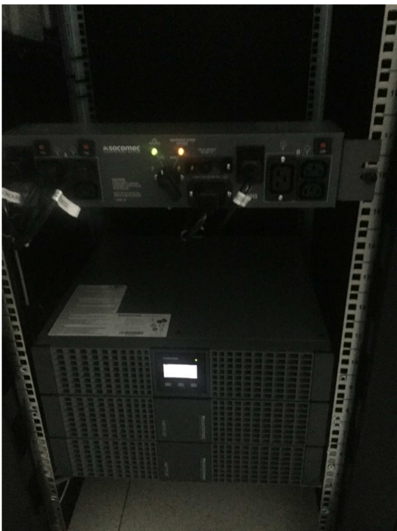
Vue onduleur et by pass en rack
