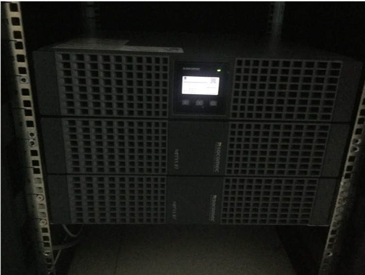
onduleur et batterie d'extension
