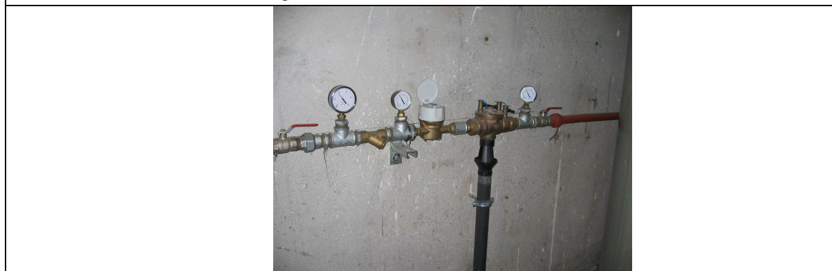
Ci-dessous vue générale d'une alimentation avec disconnecteur et manos.
