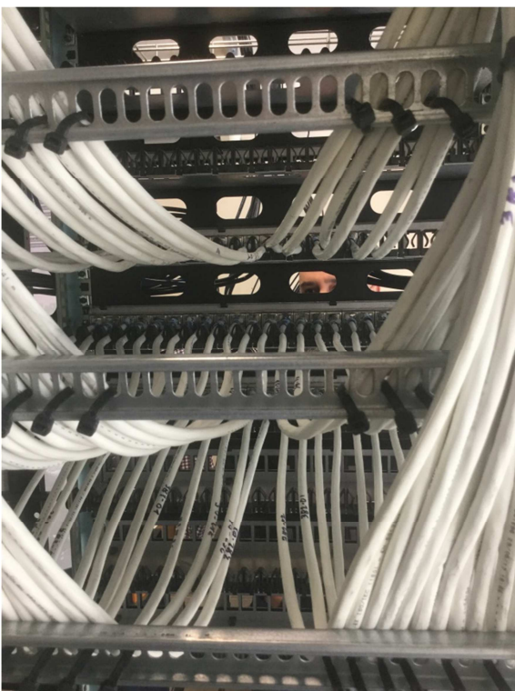
Câblage arrière direct sans mou et câbles attachés sur l'échelle à l'arrière de la baie qui permet de maintenir un accès pour les interventions ultérieures
