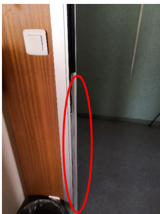
Figure 17 : Absence de joints périphériques sur tout le pourtour de la porte / DIRRECTE 209
