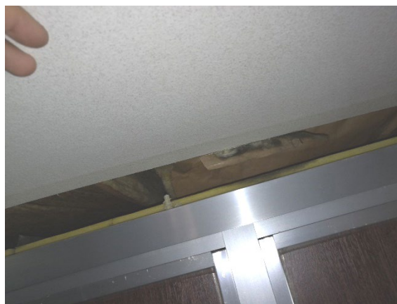
Figure 20 : Absence d'une imposte / COPIEUR 209 bis – BAEC 211
