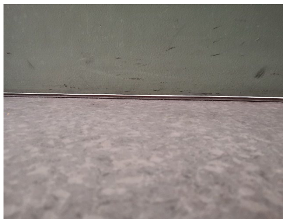
Figure 18 : Absence de joint balais / DIRRECTE 209
