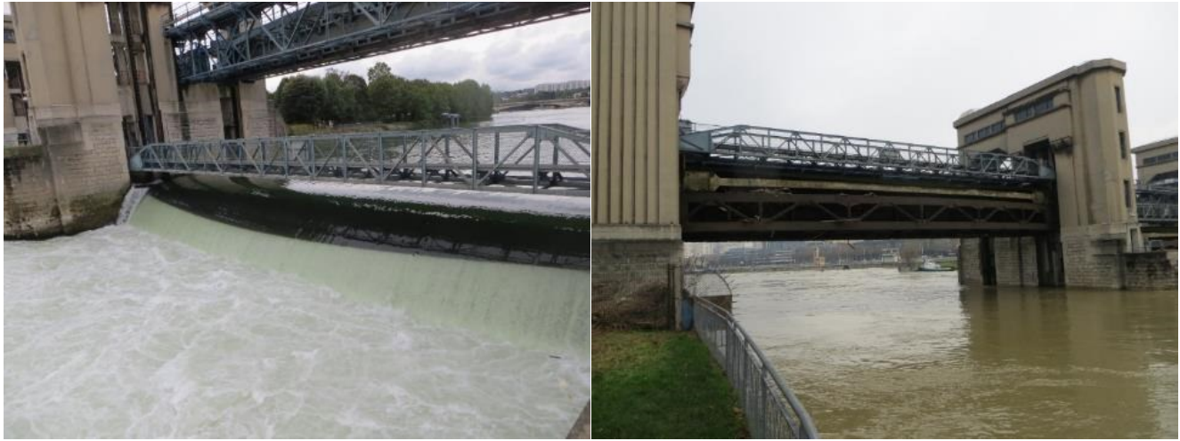
Figure 3 : Vannes du BAVA (en régulation et relevées)
