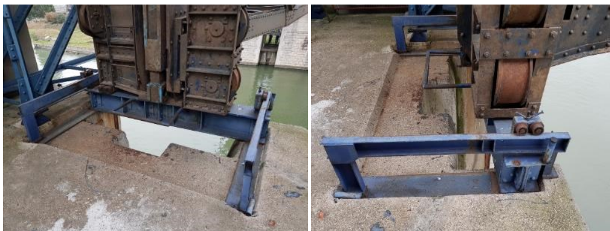
Figure 7 : Dispositif d'appui existant de type « roulettes de soulèvement »
