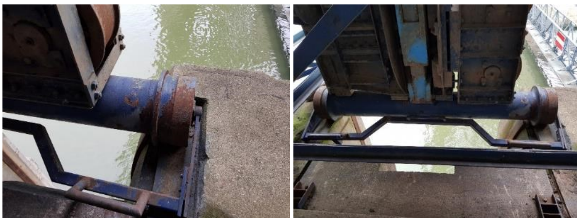
Figure 5 : Dispositif d'appui existant de type « rouleaux »
