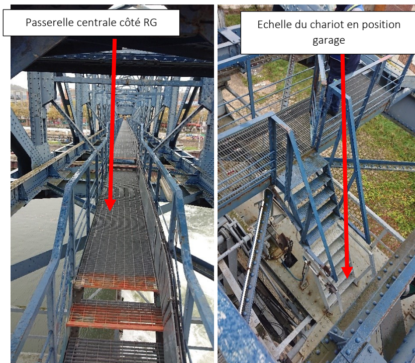
Figure 15 : Vues des accès à la passerelle centrale et au chariot en position garage
