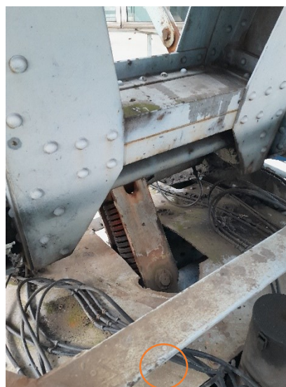
Vue en-plongée sur la plateforme inférieure Suspension supérieure du câble (côté aval) Système de détente des rondelles (orange) Photo 4
