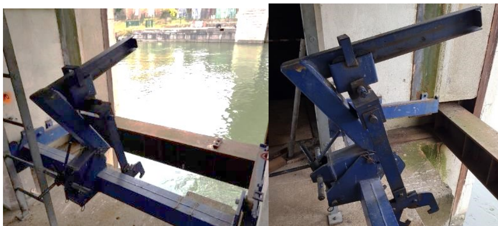
Figure 6 : Dispositif d'appui existant de type « potence en Z »
