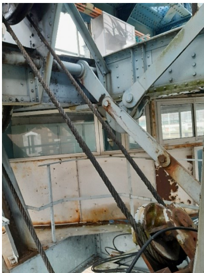
Vues sur la plateforme basse du chariot (photo 1 et 2 de droite à gauche) Suspension supérieure du câble : poulie du câble et système d'accroche du « chapeau » (en orange)
