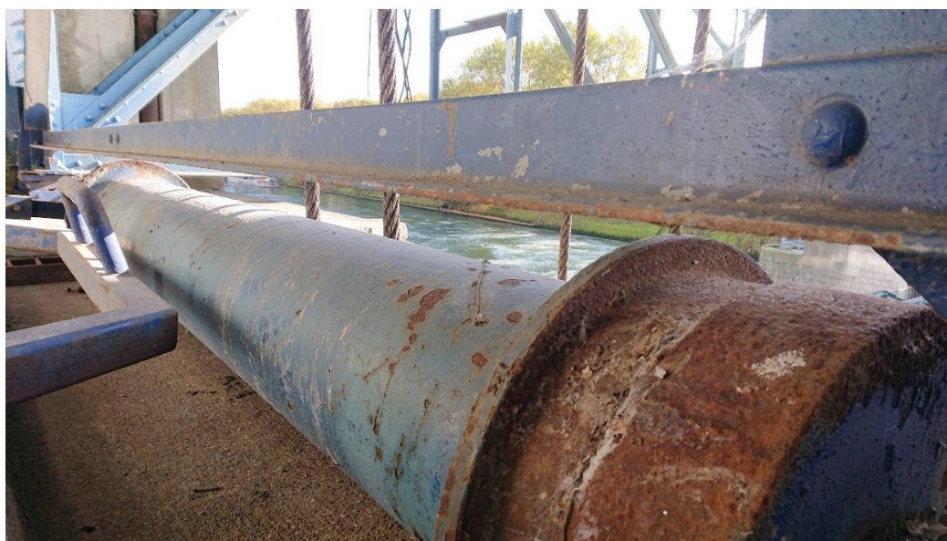
Figure 20 : Vue du jeu actuel entre le rouleau et une traverse du pont
