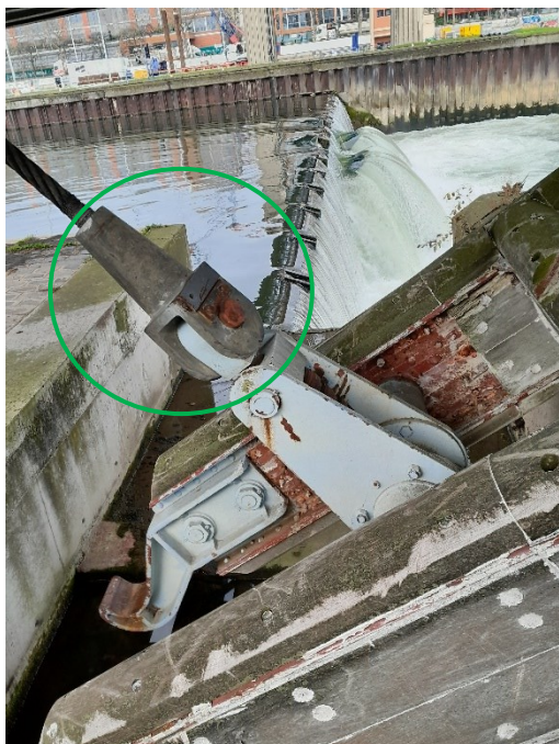
Vue du système de fixation inférieur depuis la zone de garage du chariot Ecrou de mise sous tension des rondelles belleville identifié en orange Noix permettant la liaison entre le système de tension inférieur et le câble (identifié en vert) Photos 5 et 6 de droite à gauche
