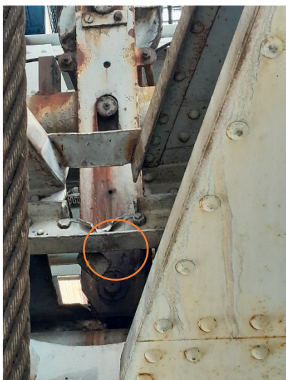
Vue en contre-plongée depuis le bord de la fosse de garage Suspension supérieure du câble (côté amont) Système de détente des rondelles (orange) Photo 3
