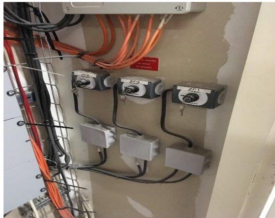
Locaux SSI d'étage avec les AES et les commandes de réarmements des CCFs et VCFs
