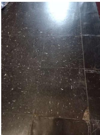
Prélèvement - P34 : R+3 / Dégagement sanitaires - Dalle de sol - (Présence d'amiante)
