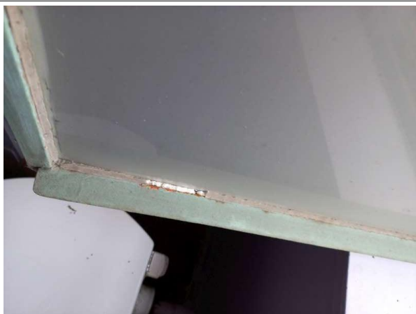
Prélèvement - P404 : Entresol R+1 / Logement 2 / WC 1 - Joint de vitrage- (Absence d'amiante)
