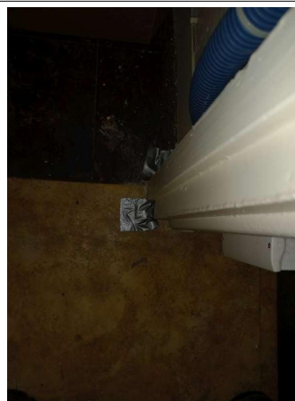
Prélèvement - P43 : R+3 / Bureau 8 - Dalle de sol- (Présence d'amiante)
