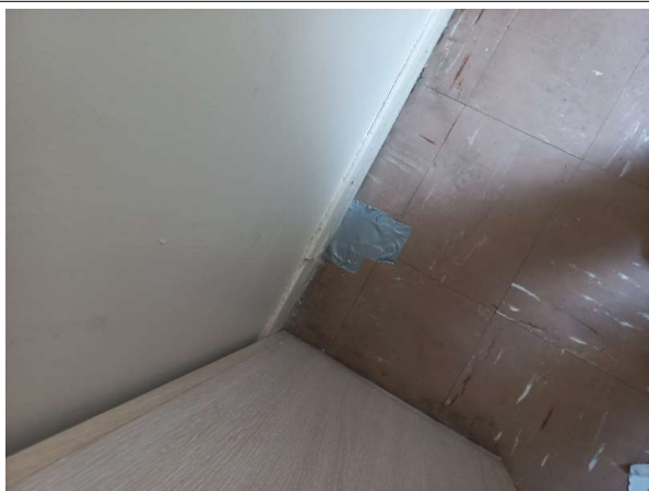
Prélèvement - P54 : R+3 / Couloir A - Dalle de sol- (Présence d'amiante)
