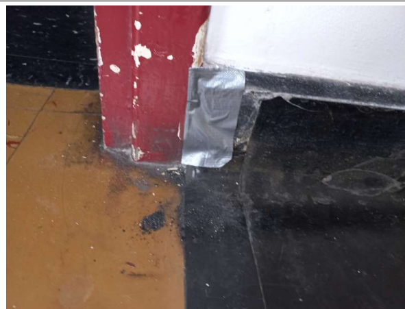
Prélèvement - P31 : R+3 / Couloir B - Dalle de sol- (Présence d'amiante)
