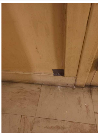
Prélèvement - P217 : R+1 / Couloir B - Enduit- (Présence d'amiante)
