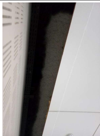
Prélèvement - P456 : R+1 / Couloir B - Flocage- (Absence d'amiante)
