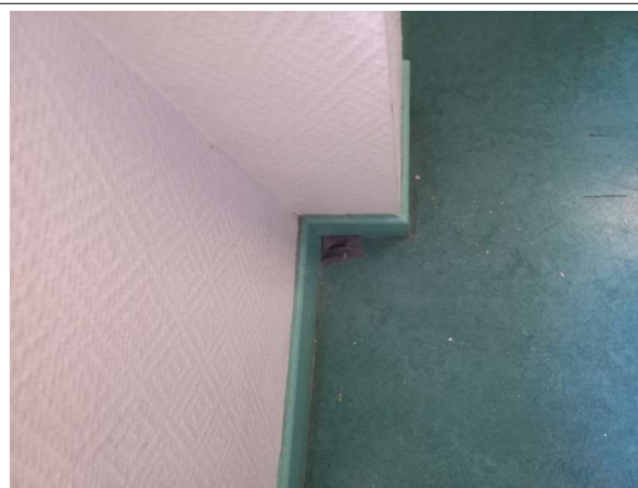
Prélèvement - P218 : R+2 / Cuisine - Colle- (Absence d'amiante)
