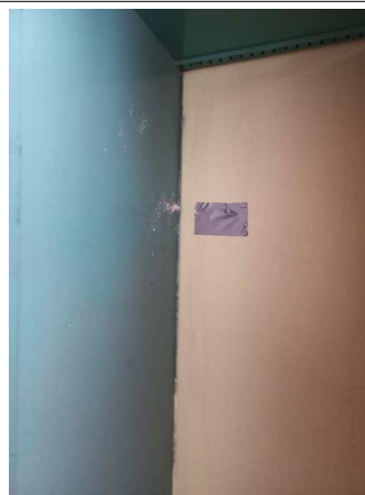
Prélèvement - P14 : R+4 / Bibliothèque - Enduit- (Absence d'amiante)
