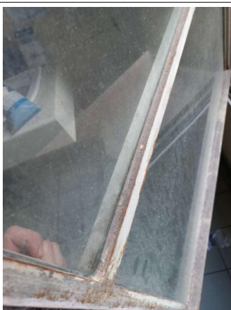
Prélèvement - P211 : R+1 / Sanitaires + WC couloir B - Mastic- (Absence d'amiante)
