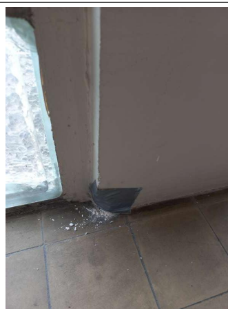
Prélèvement - P28 : R+3 / Palier escalier C - Enduit- (Absence d'amiante)
