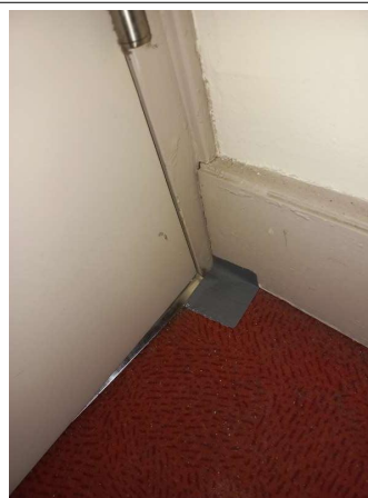
Prélèvement - P202 : R+1 / Bureau 32 - Colle- (Présence d'amiante)
