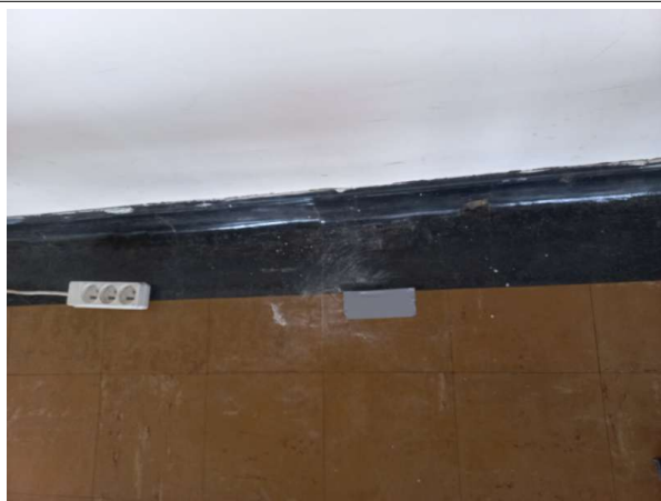
Prélèvement - P30 : R+3 / Salle de cours 1 - Colle bitumineuse- - (Présence d'amiante)
