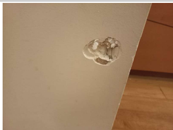
Prélèvement - P356 : R+0 / Amphithéâtre - Enduit- (Absence d'amiante)
