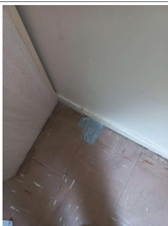
Prélèvement - P57 : R+3 / Bureau 5 - Dalle de sol- (Présence d'amiante)
