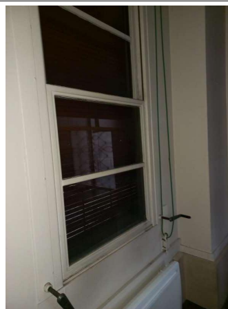
Prélèvement - P360 : R+0 / Hall d'entrée - Joint de vitrage- (Absence d'amiante)
