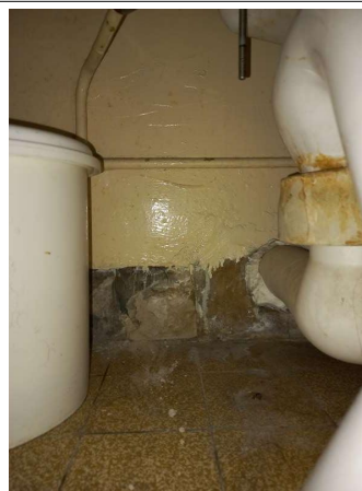
Prélèvement - P49 : R+3 / Sanitaires + WC 2 - Colle de plinthe- (Absence d'amiante)
