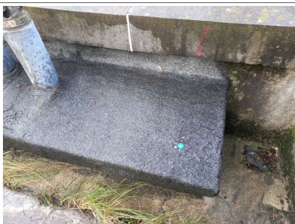
Prélèvement - P349 : R+2 / Toiture-terrasse - Complexe d'étanchéité asphalté- (Présence d'amiante)
