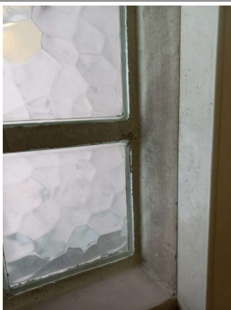
Prélèvement - P173 : Entresol R+1 / Salle informatique - Joint- (Absence d'amiante)
