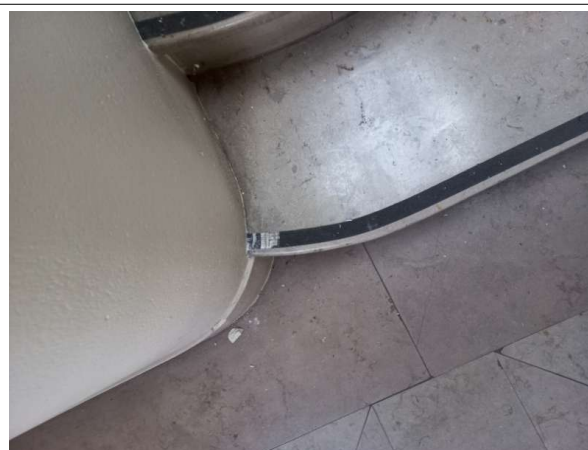
Prélèvement - P310 : R+4 / Escalier B - Nez de marche- (Absence d'amiante)
