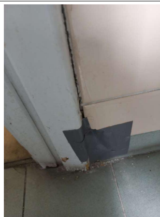
Prélèvement - P208 : R+1 / Sanitaires + WC couloir B - Colle de plinthe- (Absence d'amiante)
