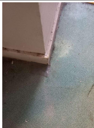
Prélèvement - P270 : R+0 / Dégagement sanitaires - Colle- (Absence d'amiante)
