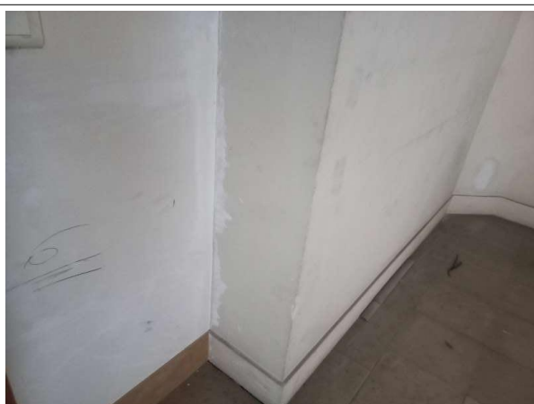
Prélèvement - P325 : R+2 / Palier escalier A - Enduit- (Absence d'amiante)
