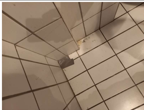
Prélèvement - P157 : R+1 / Sanitaires + WC informatique - Colle de carrelage- (Absence d'amiante)
