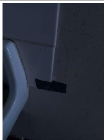
Prélèvement - P155 : R+1 / Palier escalier C - Colle de faïence- (Absence d'amiante)
