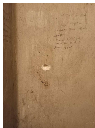
Prélèvement - P83 : R-1 / Machinerie ascenseur - Enduit- (Absence d'amiante)
