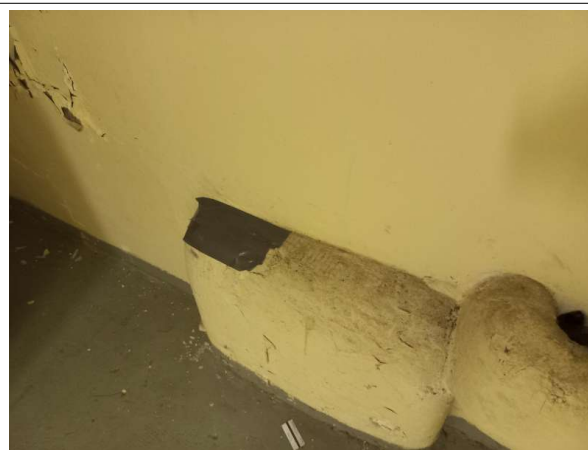
Prélèvement - P105 : R-1 / Dégagement - Enduit- (Présence d'amiante)
