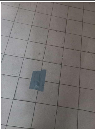
Prélèvement - P235 : R+0 / Dégagement 1 - Colle de carrelage- (Absence d'amiante)
