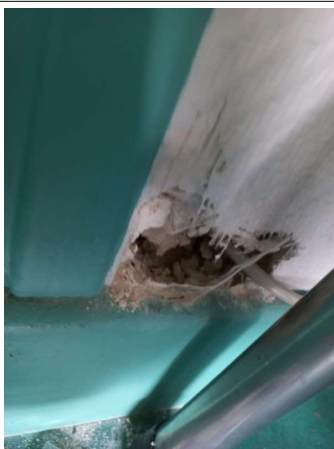
Prélèvement - P221 : R+2 / Bureau 10 - Enduit- (Absence d'amiante)
