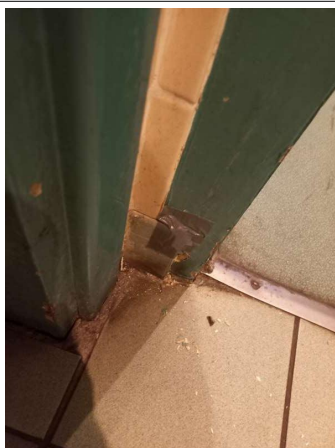
Prélèvement - P265 : R+0 / Sanitaires + WC 1 - Colle de plinthe - (Absence d'amiante)
