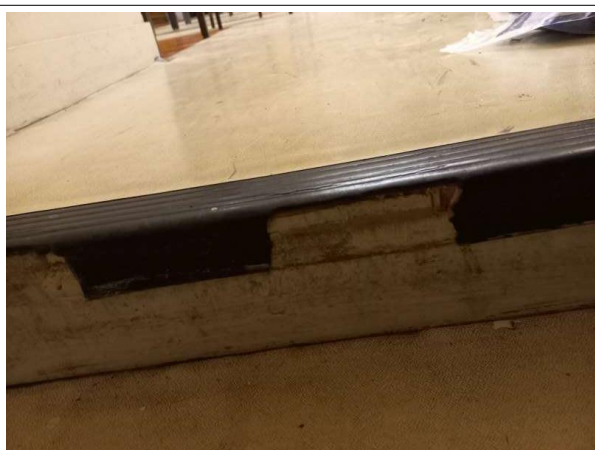
Prélèvement - P181 : Entresol R+1 / Dégagement - Nez de marche- (Absence d'amiante)
