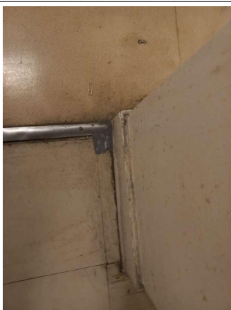
Prélèvement - P213 : R+1 / Couloir B - Dalle de sol- (Présence d'amiante)
