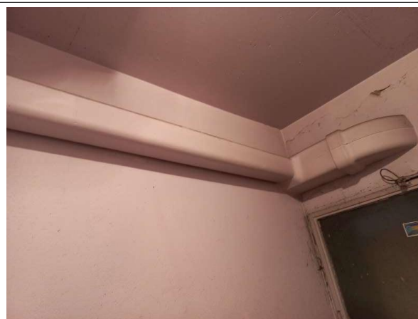
Déclaré - : R-1 / Local - Conduit- (Présence d'amiante)
