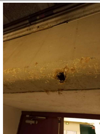
Prélèvement - P137 : R-1 / Couloir A - Enveloppe de calorifugeage- (Absence d'amiante)
