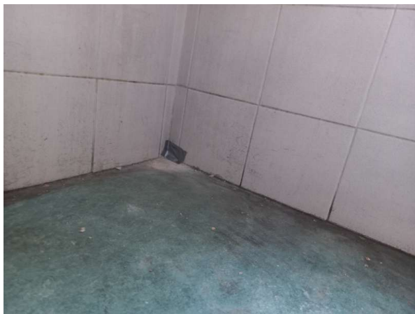
Prélèvement - P73 : R+2 / Sanitaires + WC 1 - Colle de faïence - (Absence d'amiante)
