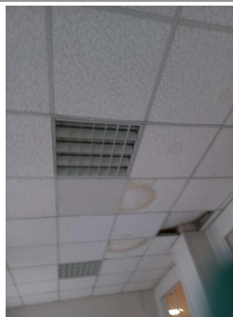
Prélèvement - P342 : R+1 / Bureau 5 - Faux plafond- (Absence d'amiante)
