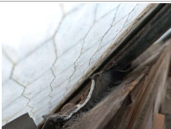
Prélèvement - P309 : R+5 / Combles - Joint de vitrage- (Absence d'amiante)
