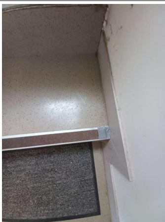
Prélèvement - P191 : R+1 / Couloir A - Nez de marche- (Absence d'amiante)
