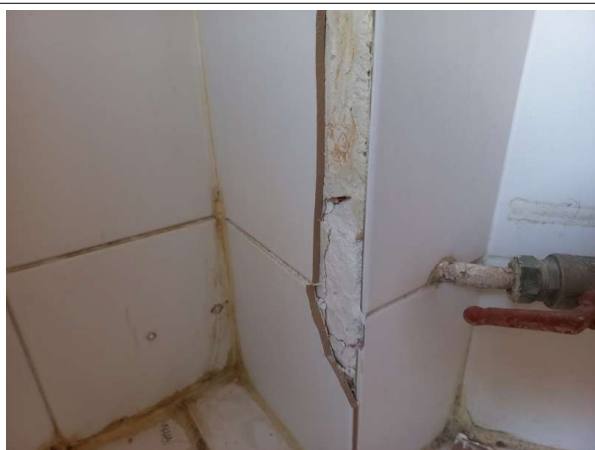
Prélèvement - P388 : Entresol R+1 / Logement 1 / Salle d'eau - Colle de faïence- (Absence d'amiante)
