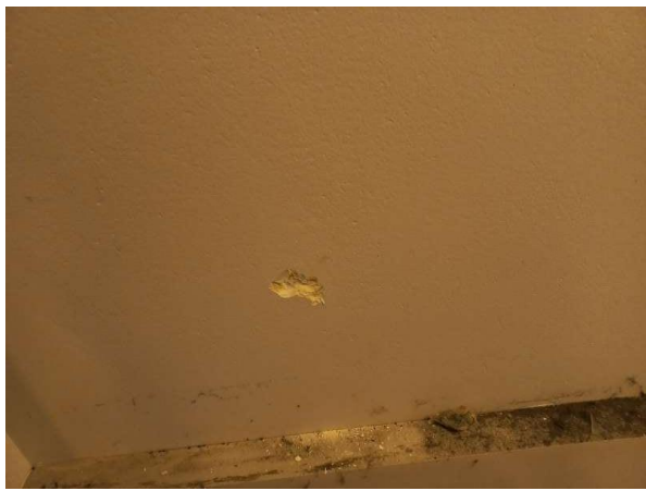
Prélèvement - P374 : R+0 / Circulation - Enduit- (Absence d'amiante)
