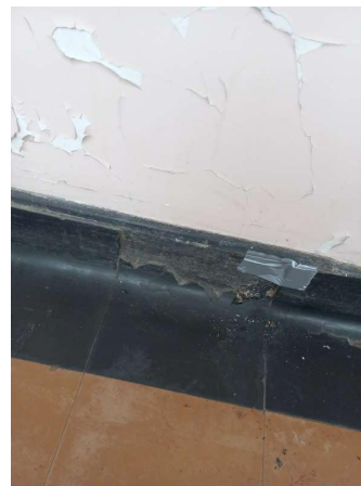
Prélèvement - P33 : R+3 / Couloir B - Dalle de sol- (Présence d'amiante)
