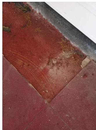
Prélèvement - P316 : R+3 / Réserve - Sol coulé- (Absence d'amiante)
