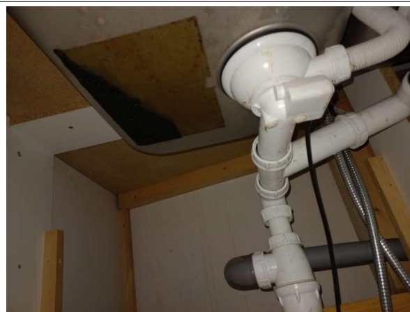
Prélèvement - P367 : R+0 / Cafétéria - Plaque souple bitumineuse antivibratile- (Absence d'amiante)
