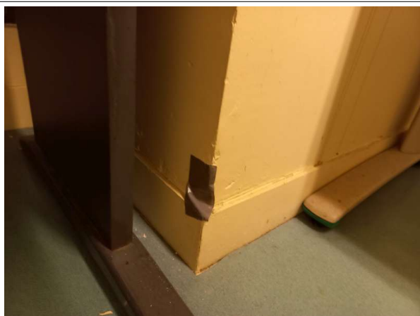
Prélèvement - P177 : Entresol R+1 / Réserve - Enduit- (Absence d'amiante)
