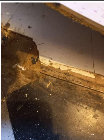
Prélèvement - P386 : Entresol R+1 / Logement 1 / Salle d'eau - Dalle de sol- (Présence d'amiante)
