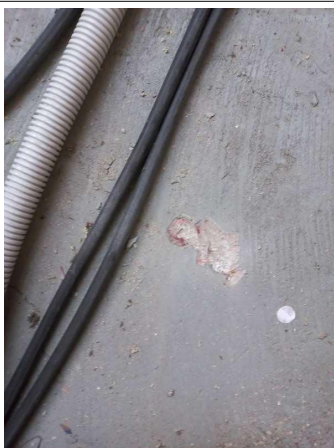
Prélèvement - P483 : R+1 / Salle informatique - Peinture sur béton- (Absence d'amiante)
