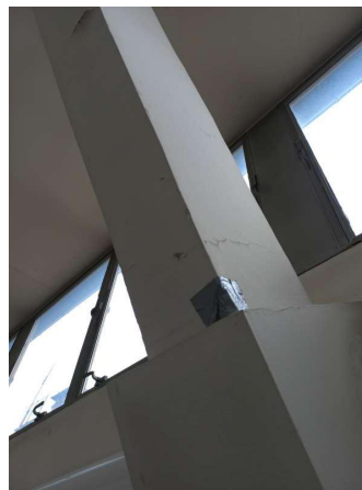
Prélèvement - P12 : R+4 / Bibliothèque - Enduit- (Présence d'amiante)
