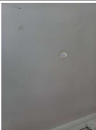
Prélèvement - P339 : R+1 / Bureau 9 - Enduit- (Absence d'amiante)
