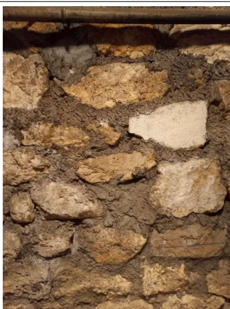
Prélèvement - P148 : R-1 / Cave 0 - Joint d'assemblage- (Absence d'amiante)
