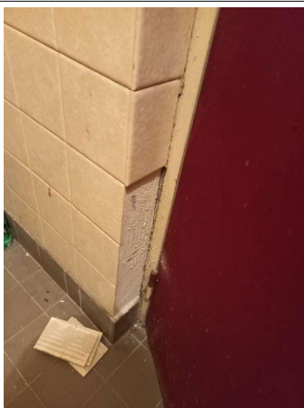
Prélèvement - P102 : R-1 / Sanitaires + WC - Colle de faïence- (Absence d'amiante)
