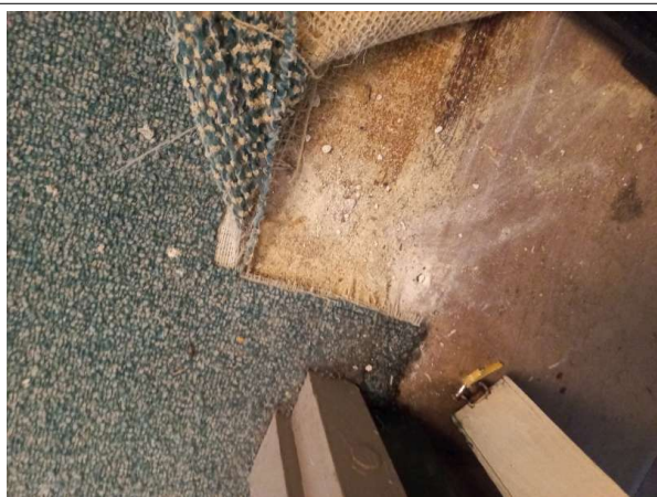
Prélèvement - P313 : R+3 / Salle de réunion - Colle bitumineuse- (Présence d'amiante)
