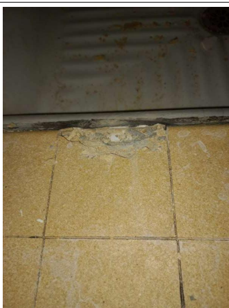
Prélèvement - P425 : Entresol R+1 / Logement 2 / Salle d'eau 2 - Colle de faïence- (Absence d'amiante)
