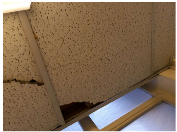
Prélèvement - P375 : R+0 / Salle de réunion - Faux plafond- (Absence d'amiante)
