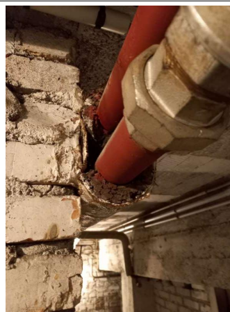
Prélèvement - P145 : R-1 / Couloir A - Enveloppe de calorifugeage- (Absence d'amiante)
