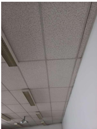
Prélèvement - P160 : R+1 / Salle informatique - Faux plafond- (Absence d'amiante)
