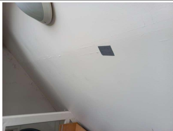
Prélèvement - P10 : R+4 / Mezzanine - Bande calicot- (Absence d'amiante)
