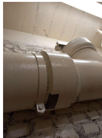
Prélèvement - P290 : R-2 / Archives 1 - Conduit- (Présence d'amiante)
