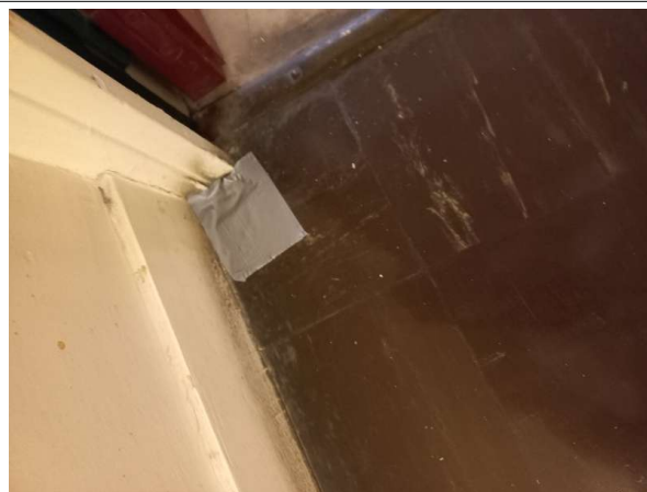
Prélèvement - P56 : R+3 / Couloir A - Dalle de sol- (Présence d'amiante)
