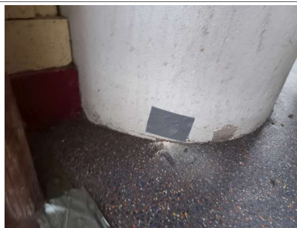
Prélèvement - P272 : R+0 / Gymnase - Enduit- (Absence d'amiante)
