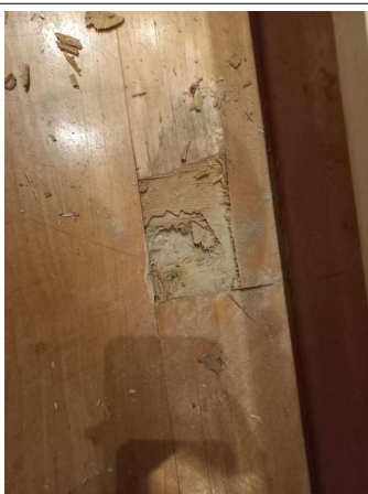
Prélèvement - P355 : R+0 / Amphithéâtre - Ragréage- (Absence d'amiante)
