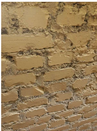
Prélèvement - P289 : R-2 / Archives 1 - Joint d'assemblage- (Absence d'amiante)
