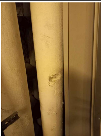
Prélèvement - P138 : R-1 / Couloir A - Enveloppe de calorifugeage- (Absence d'amiante)
