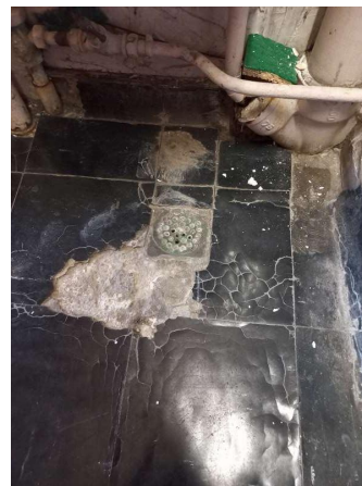
Prélèvement - P35 : R+3 / Dégagement sanitaires - Dalle de sol - (Présence d'amiante)
