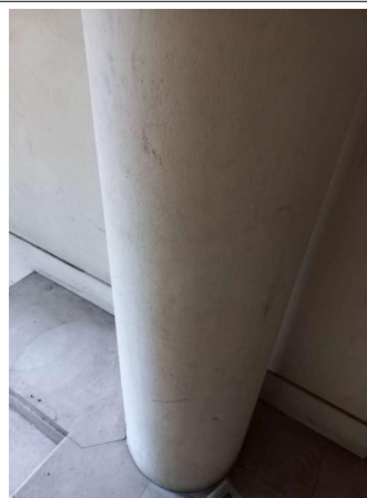
Prélèvement - P431 : R+0 / Parties communes logements / Hall d'entrée - Enduit- (Absence d'amiante)
