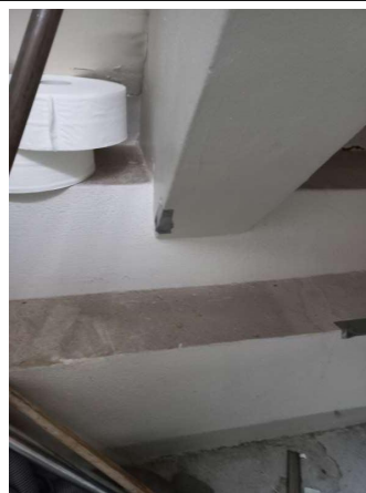
Prélèvement - P22 : R+4 / Réserve 1 - Enduit- (Absence d'amiante)
