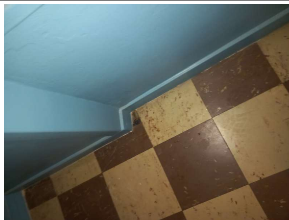
Prélèvement - P393 : Entresol R+1 / Logement 1 / Chambre 2 - Colle bitumineuse- (Présence d'amiante)
