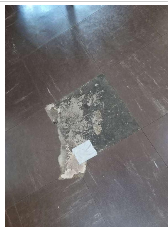
Prélèvement - P58 : R+3 / Bureau 9 - Colle bitumineuse- (Présence d'amiante)
