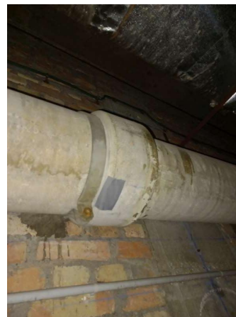
Prélèvement - P292 : R-2 / Dégagement 1 - Conduit- (Présence d'amiante)
