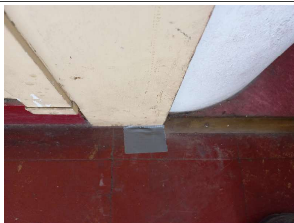
Prélèvement - P260 : R+0 / Dégagement 3 - Colle bitumineuse- (Présence d'amiante)
