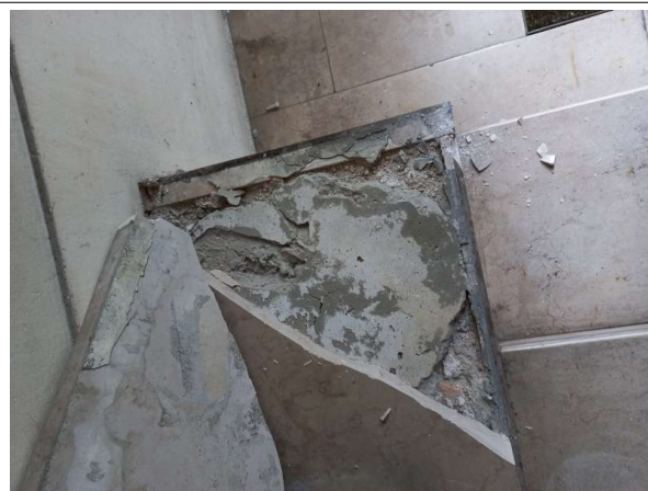
Prélèvement - P429 : R+0 / Parties communes logements / Hall d'entrée - Colle- (Absence d'amiante)
