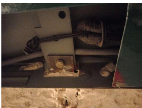
Prélèvement - P84 : Tout étage / Ascenseur - Enduit- (Absence d'amiante)
