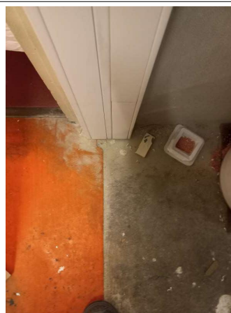
Prélèvement - P256 : R+0 / Réserve 3 - Colle- (Présence d'amiante)
