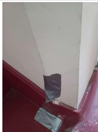
Prélèvement - P02 : R+4 / Palier escalier C - Enduit- (Absence d'amiante)
