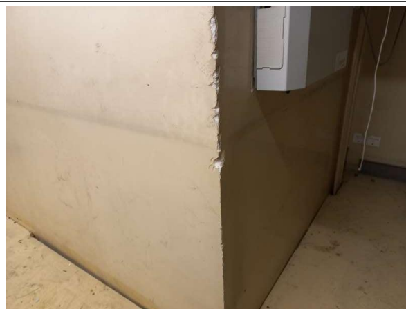
Prélèvement - P373 : Entresol R+1 / Local technique 2 - Enduit- (Absence d'amiante)
