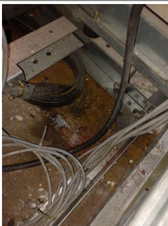
Prélèvement - P92 : R+4 / Monte-charge - Colle bitumineuse- (Présence d'amiante)
