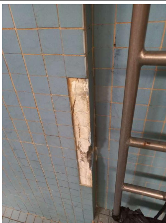
Prélèvement - P132 : R-1 / Piscine - Colle de faïence- (Absence d'amiante)
