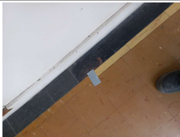
Prélèvement - P68 : R+2 / Couloir B - Colle bitumineuse- (Présence d'amiante)
