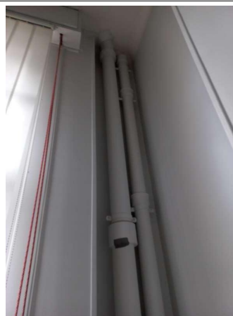
Prélèvement - P164 : R+1 / Bureau 1 - Conduit- (Présence d'amiante)
