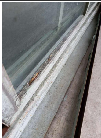
Prélèvement - P318 : R+2 / Bureau central 3 - Joint de vitrage- (Absence d'amiante)
