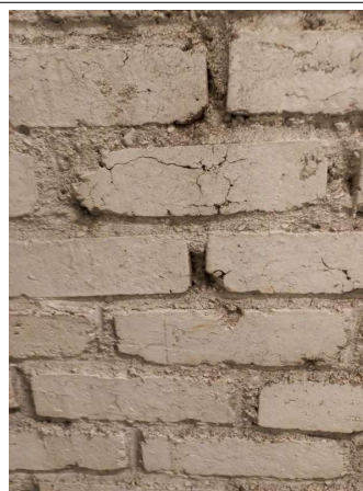
Prélèvement - P143 : R-1 / Couloir A - Joint d'assemblage- (Absence d'amiante)
