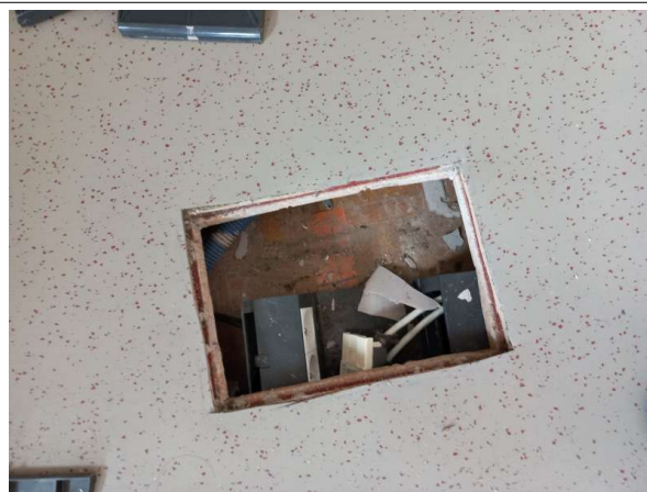
Prélèvement - P486 : R+1 / Salle de formation - Colle- (Absence d'amiante)
