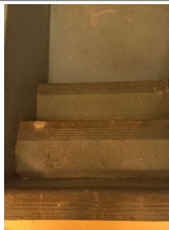
Prélèvement - P381 : Entresol R+1 / Escalier + palier bureau 1 - Nez de marche- (Absence d'amiante)
