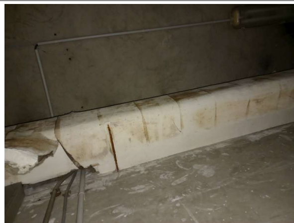
Prélèvement - P282 : R-2 / Palier escalier C - Enveloppe de calorifugeage- (Absence d'amiante)
