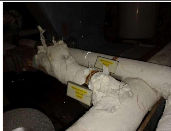
Prélèvement - P294 : R-2 / Local technique 1 - Enveloppe de calorifugeage- (Absence d'amiante)
