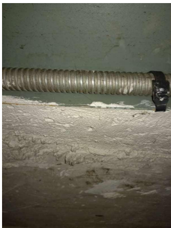
Prélèvement - P345 : Tout étage / Ascenseur - Enduit- (Absence d'amiante)
