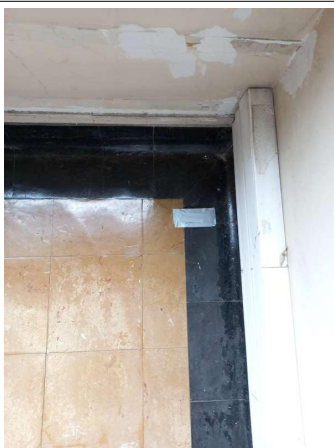
Prélèvement - P63 : R+2 / Salle de cours 2 - Colle bitumineuse- (Présence d'amiante)
