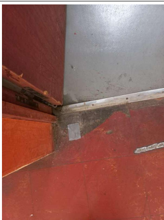
Prélèvement - P261 : R+0 / Gymnase - Colle bitumineuse- (Présence d'amiante)
