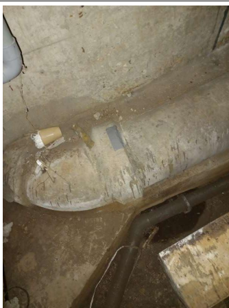
Prélèvement - P293 : R-2 / Local technique 1 - Conduit- (Présence d'amiante)
