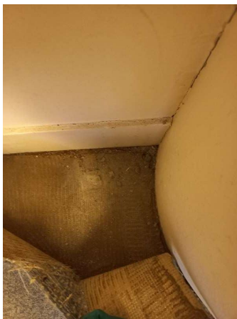
Prélèvement - P376 : R+0 / Salle de réunion - Colle bitumineuse- (Présence d'amiante)
