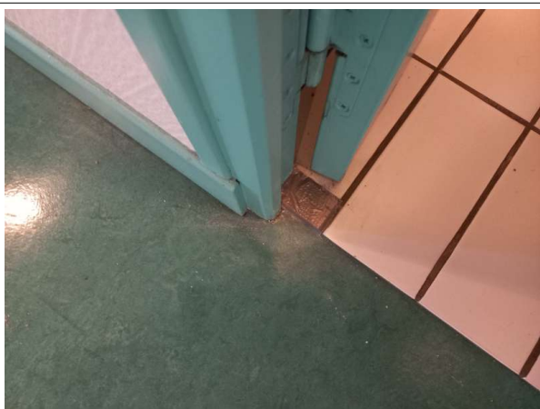
Prélèvement - P223 : R+2 / WC hommes - Colle de carrelage- (Absence d'amiante)
