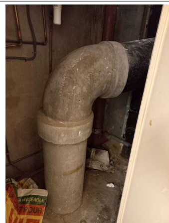
Prélèvement - P379 : R+0 / Local n° - Conduit- (Présence d'amiante)
