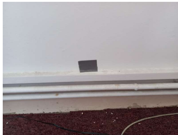
Prélèvement - P274 : R+0 / Bureau 6 - Enduit- (Absence d'amiante)
