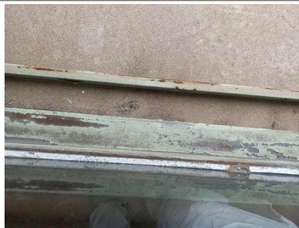
Prélèvement - P64 : R+2 / Salle de cours 2 - Mastic- (Absence d'amiante)
