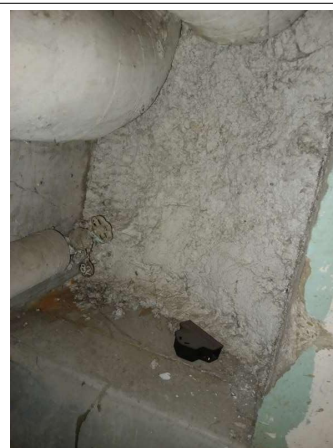
Prélèvement - P296 : R-2 / Local technique 1 - Flocage- (Absence d'amiante)
