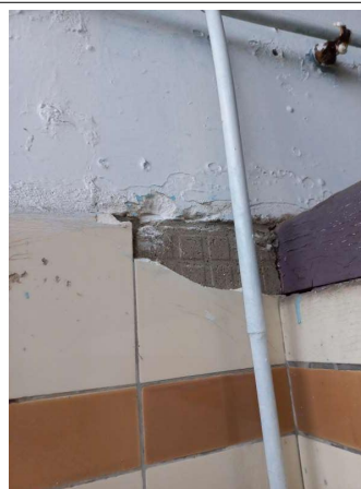
Prélèvement - P125 : R-1 / Cabines et douches piscine - Colle de faïence- (Absence d'amiante)
