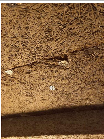
Prélèvement - P142 : R-1 / Local technique 1 - Enduit- (Absence d'amiante)
