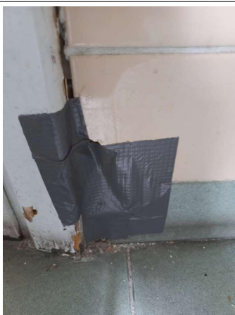
Prélèvement - P207 : R+1 / Sanitaires + WC couloir B - Colle de plinthe- (Absence d'amiante)
