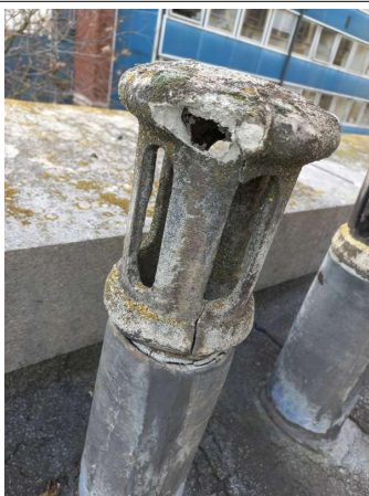
Prélèvement - P299 : R+2 / Toiture-terrasse - Mitron- (Présence d'amiante)
