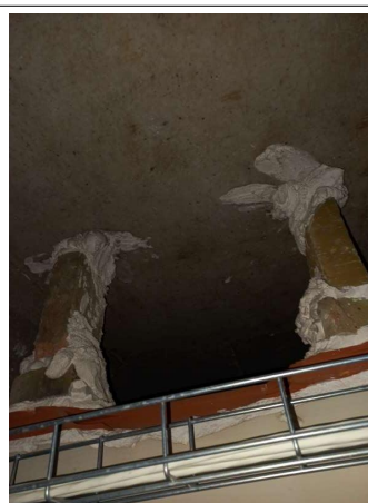
Prélèvement - P462 : R+2 / Couloir B - Enduit- (Absence d'amiante)
