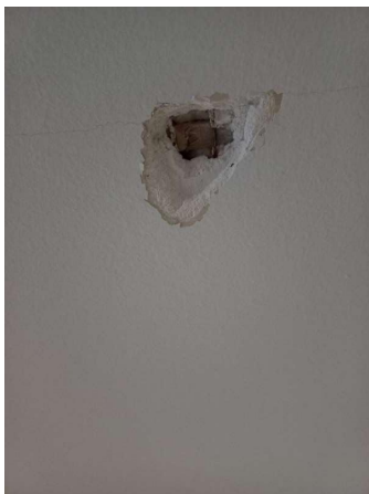
Prélèvement - P447 : R+0 / Palier escalier B - Enduit- (Absence d'amiante)
