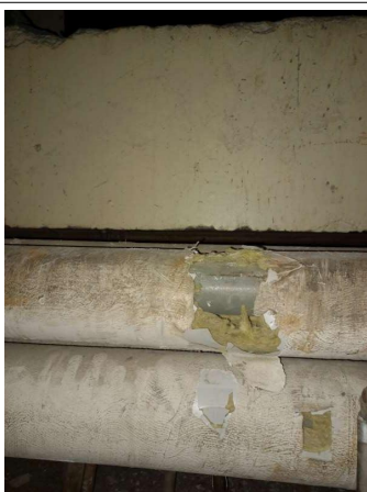
Prélèvement - P297 : R-2 / Chaufferie 2 - Enveloppe de calorifugeage- (Absence d'amiante)
