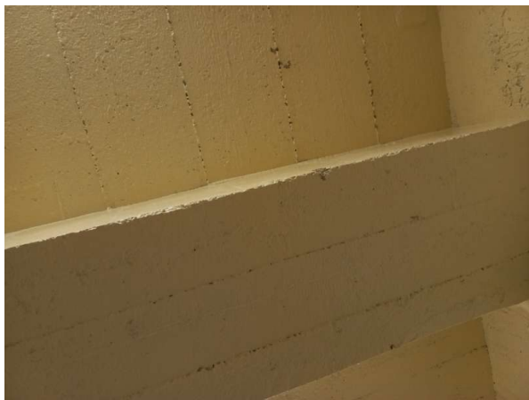
Prélèvement - P287 : R-2 / Archives 1 - Enduit- (Absence d'amiante)
