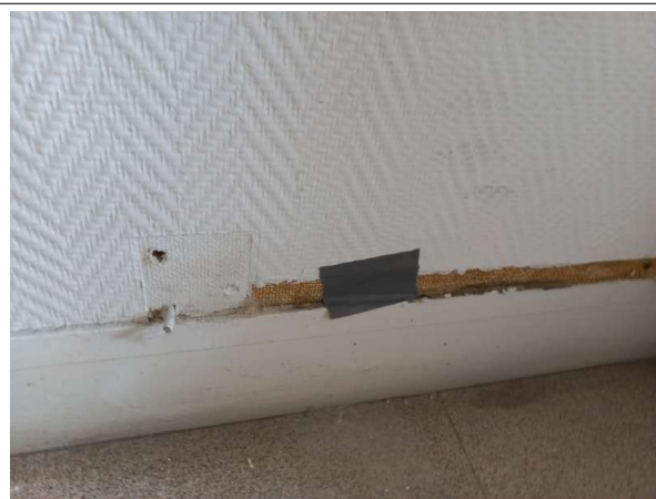
Prélèvement - P248 : R+0 / Bureau 4 - Enduit- (Absence d'amiante)
