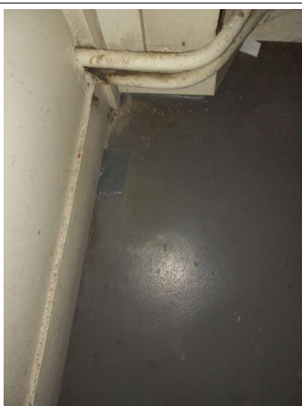
Prélèvement - P277 : R+0 / Palier escalier entresol - Colle bitumineuse- (Présence d'amiante)
