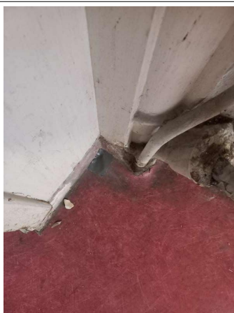
Prélèvement - P233 : R+0 / Palier escalier C - Colle- (Absence d'amiante)
