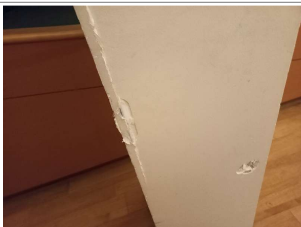
Prélèvement - P357 : R+0 / Amphithéâtre - Bande calicot- (Absence d'amiante)
