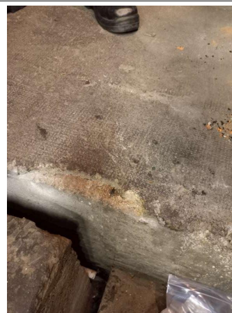
Prélèvement - P77 : R-1 / Machinerie ascenseur - Chape maigre- (Absence d'amiante)
