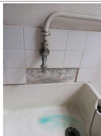
Prélèvement - P250 : R+0 / Bureau 5 - Colle de faïence- (Absence d'amiante)
