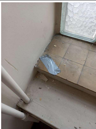
Prélèvement - P25 : R+3 / Palier escalier C - Colle de carrelage - (Absence d'amiante)
