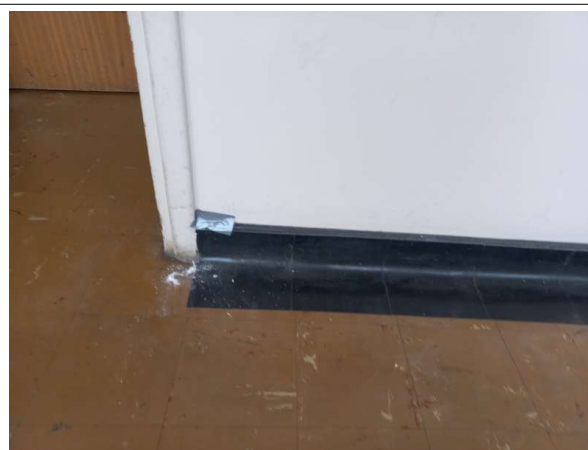
Prélèvement - P66 : R+2 / Couloir B - Enduit- (Absence d'amiante)
