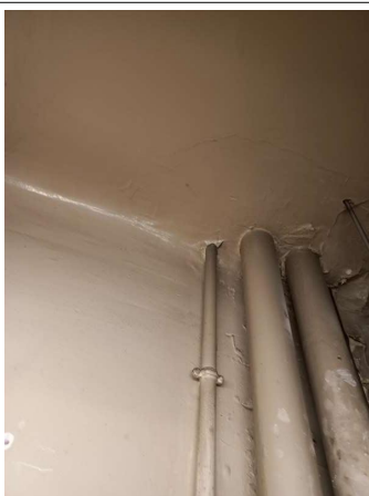
Prélèvement - P372 : Entresol R+1 / Local technique 2 - Enduit- (Absence d'amiante)
