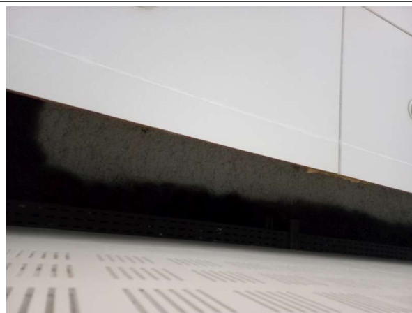
Prélèvement - P464 : R+2 / Amphithéâtre - Flocage- (Absence d'amiante)
