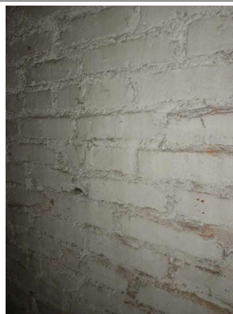
Prélèvement - P482 : R+0 / Réserve 2 - Joint d'assemblage- (Absence d'amiante)
