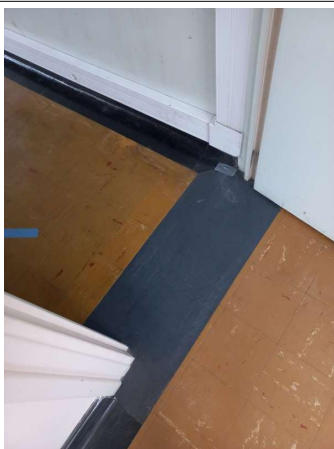
Prélèvement - P67 : R+2 / Salle de cours 3 - Colle bitumineuse- (Présence d'amiante)
