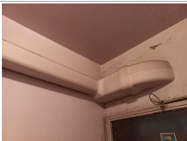
Déclaré - : R-1 / Sanitaires + WC - Conduit- (Présence d'amiante)
