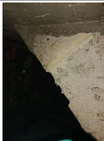
Prélèvement - P300 : R+4 / Vide derrière bibliothèque - Entourage de poutre- (Absence d'amiante)
