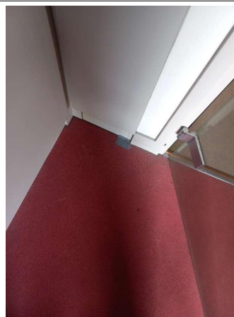
Prélèvement - P200 : R+1 / Bureau 25 - Colle- (Présence d'amiante)
