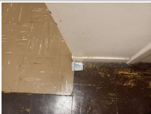
Prélèvement - P50 : R+3 / Couloir A - Dalle de sol- (Présence d'amiante)
