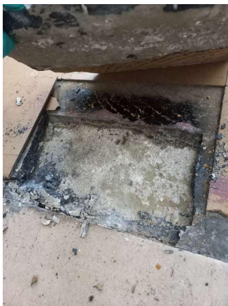
Prélèvement - P32 : R+3 / Couloir B - Colle bitumineuse- - (Présence d'amiante)
