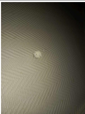
Prélèvement - P398 : Entresol R+1 / Logement 1 / Escalier - Enduit- (Présence d'amiante)
