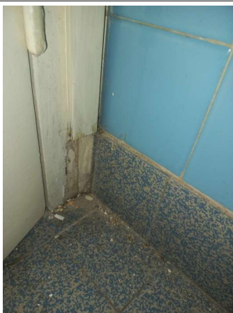
Prélèvement - P187 : Entresol R+1 / Sanitaires + WC - Colle de plinthe- (Absence d'amiante)
