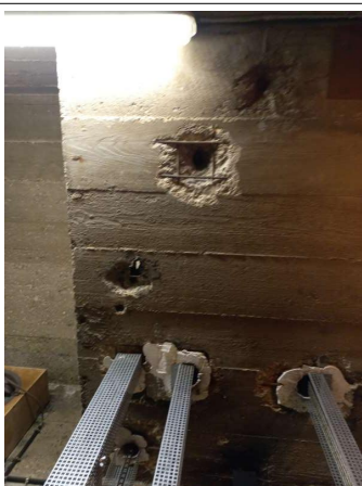
Prélèvement - P82 : R-1 / Machinerie ascenseur - Enduit- (Absence d'amiante)
