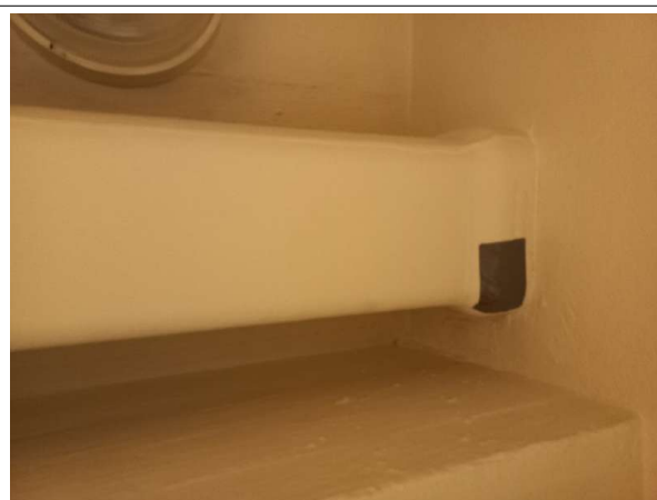
Prélèvement - P182 : Entresol R+1 / Dégagement - Conduit- (Présence d'amiante)
