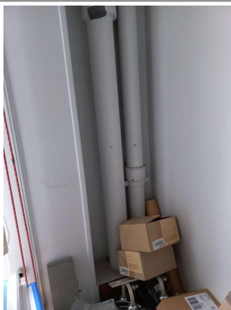
Prélèvement - P164 : R+1 / Bureau 1 - Conduit- (Présence d'amiante)
