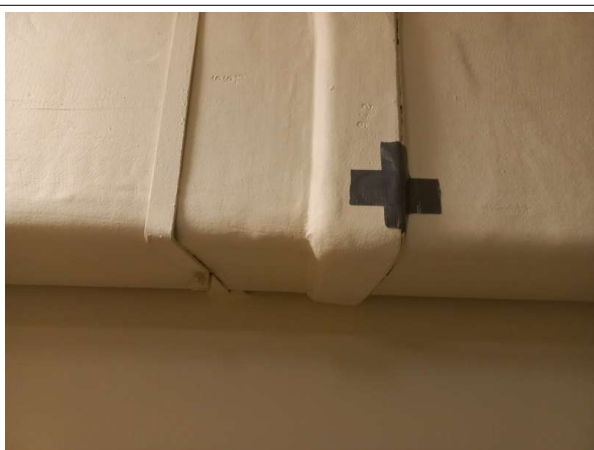
Prélèvement - P110 : R-1 / Dégagement - Conduit- (Présence d'amiante)
