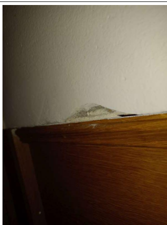
Prélèvement - P337 : R+1 / Palier escalier B - Enduit- (Absence d'amiante)
