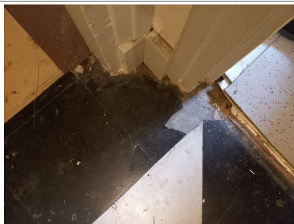
Prélèvement - P391 : Entresol R+1 / Logement 1 / Palier - Colle bitumineuse- (Présence d'amiante)
