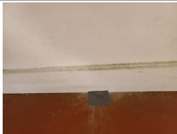
Prélèvement - P174 : Entresol R+1 / Salle informatique - Colle- (Absence d'amiante)
