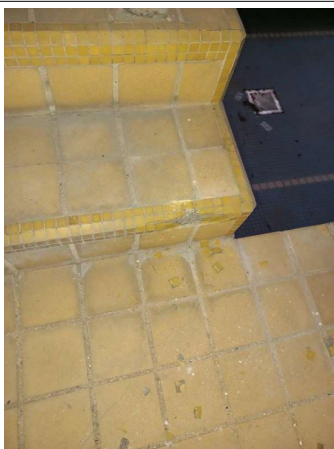
Prélèvement - P114 : R-1 / Circulation piscine - Colle de carrelage- (Absence d'amiante)
