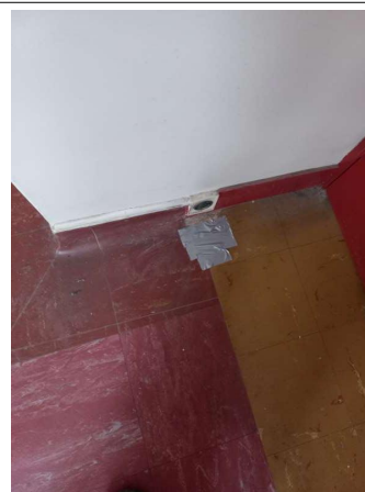
Prélèvement - P60 : R+2 / Palier escalier C - Colle bitumineuse- (Présence d'amiante)
