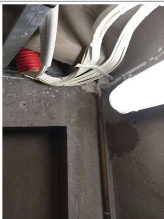
Prélèvement - P255 : R+0 / Réserve 3 - Enduit- (Absence d'amiante)
