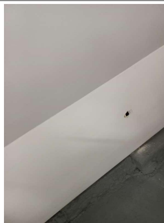
Prélèvement - P20 : R+5 - Enduit- (Absence d'amiante)
