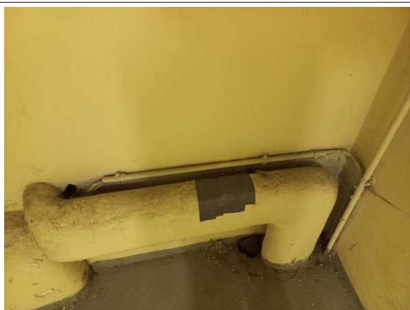
Prélèvement - P104 : R-1 / Dégagement - Enveloppe de calorifugeage- (Absence d'amiante)
