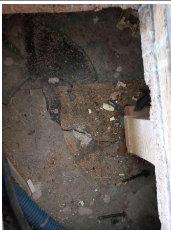
Prélèvement - P487 : R+1 / Salle de formation - Dalle de sol- (Présence d'amiante)
