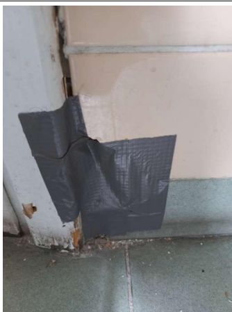
Prélèvement - P209 : R+1 / Sanitaires + WC couloir B - Colle de faïence- (Absence d'amiante)
