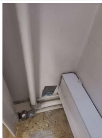
Prélèvement - P45 : R+3 / Bureau 8 - Enduit- (Absence d'amiante)
