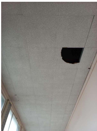
Prélèvement - P315 : R+3 / Couloir B - Faux plafond- (Absence d'amiante)
