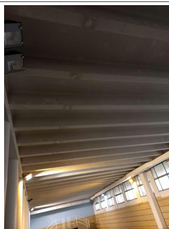
Prélèvement - P468 : R-1 / Circulation piscine - Enduit- (Absence d'amiante)
