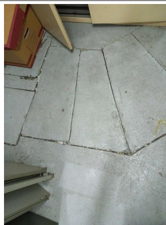
Prélèvement - P151 : R-1 / Réserve 1 - Peinture sur béton- (Absence d'amiante)
