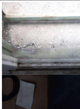
Prélèvement - P163 : R+1 / Bureau 1 - Mastic- (Absence d'amiante)
