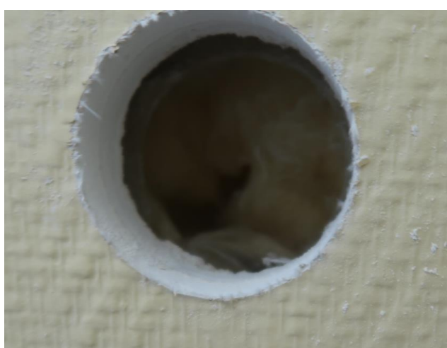
Vue de l'intérieur d'une cloison type : 2 plaques de plâtre sur laine minérale sur 2 plaques de plâtre
