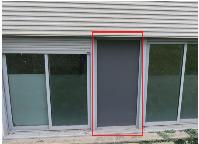
Vue depuis l'extérieur de l'extérieur de la partie opaque séparant 2 fenêtres de 2 locaux séparés par une cloison
