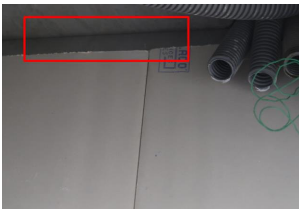
Fuite acoustiques : rail supérieur de la cloison laissé apparent
