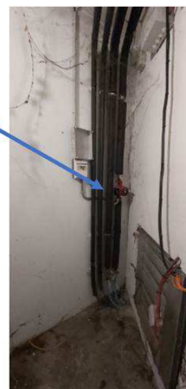
Pompe de circulation chauffage
