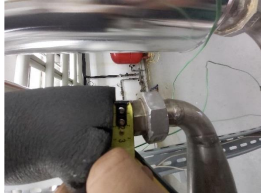
Tuyauterie de retour principale bouclage DN 20 mm
