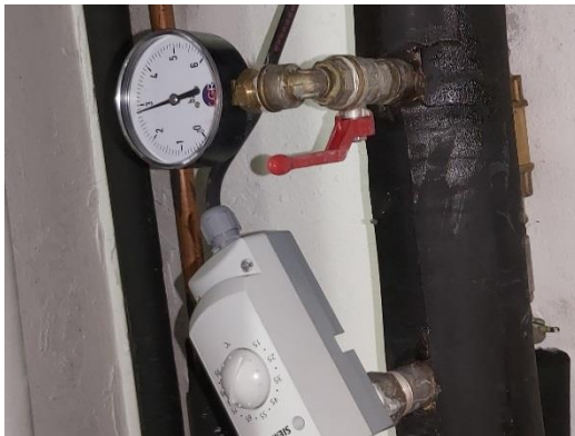
Sonde de température et manomètre sur l'ECS
