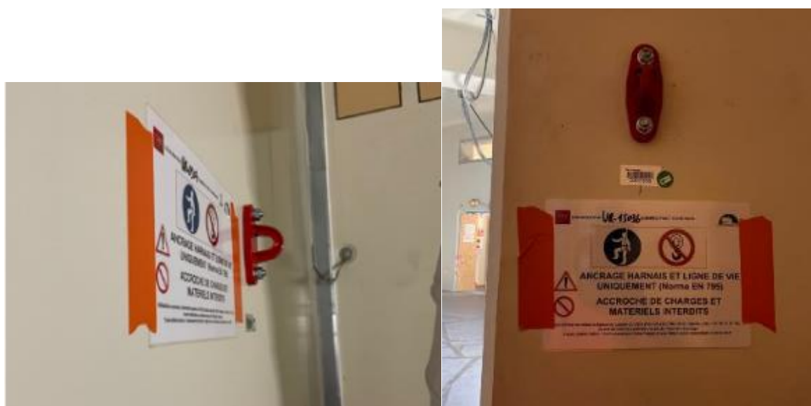
Figure 1: points d'ancrages à disposition dans le bâtiment
