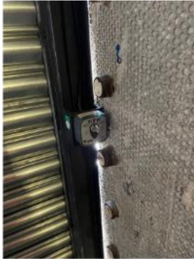
Figure 4 : boîtier de commande d'ouverture du rideau métallique
