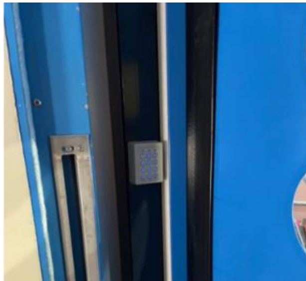
Figure 6 : boîtier à code contrôlant l'ouverture du rideau
