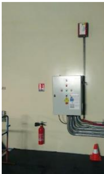
Figure 8: armoire de commande de la porte du SAS Camion
