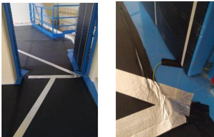
Figure 20 : bande scotch alu et liaison à la terre
