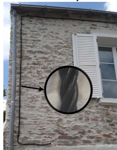
Réseau fils isolés façade BT
