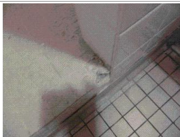
Prélèvement - P30 : CPAM / RDC / SANITAIRES - Colle de carrelage- (Absence d'amiante)
