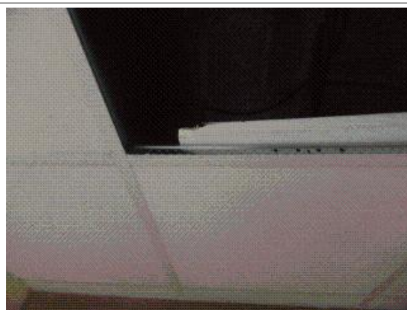
Prélèvement - P36 : CPAM / RDC / ENT.FOURNI - Faux plafond- (Absence d'amiante)
