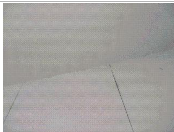
Prélèvement - P24 : CPAM / RDC / VEST - Enduit projeté- (Absence d'amiante)
