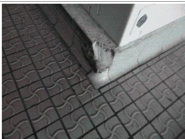
Prélèvement - P5 : CPAM / RDC / CUISINE - Colle de plinthe- (Absence d'amiante)
