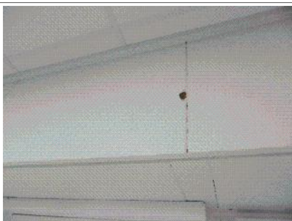
Prélèvement - P27 : CPAM / RDC / SALLE RESTO - Enduit projeté- (Absence d'amiante)
