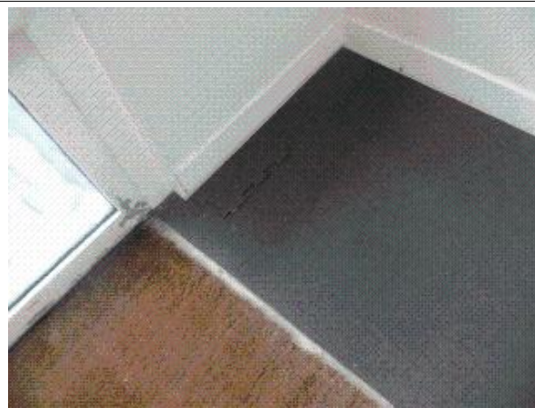
Prélèvement - P32 : CPAM / RDC / SALLE RESTO - Ragréage- (Absence d'amiante)
