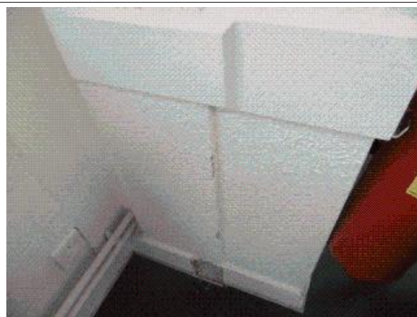
Prélèvement - P34 : CPAM / RDC / SALLE RESTO - Enduit- (Absence d'amiante)
