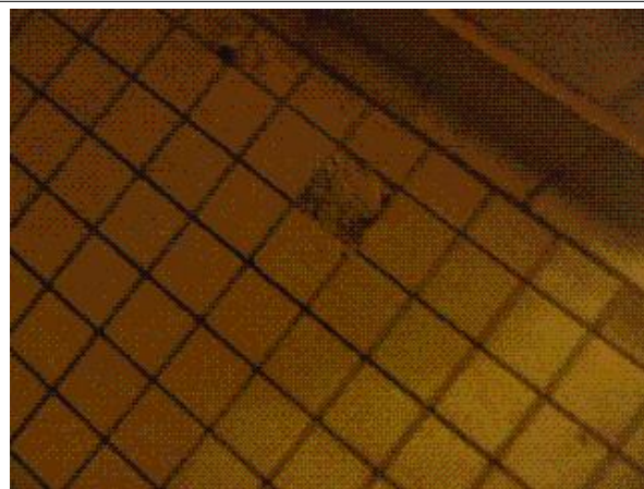
Prélèvement - P8 : CPAM / RDC / VEST - Colle de carrelage- (Absence d'amiante)
