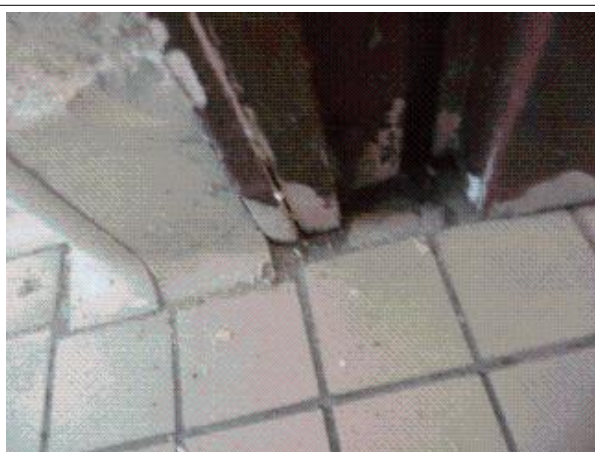
Prélèvement - P21 : CPAM / RDC / CUISINE - Peinture- (Absence d'amiante)
