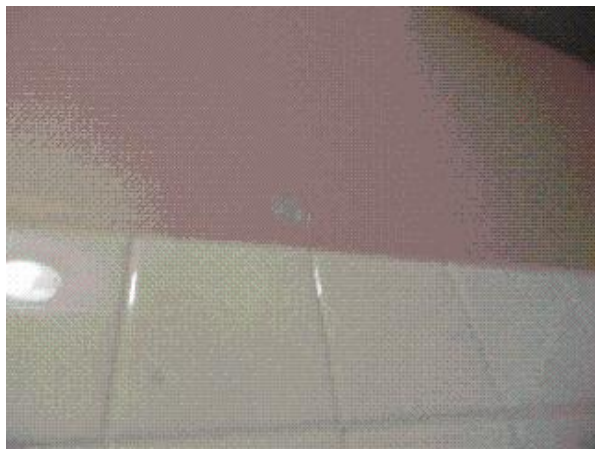
Prélèvement - P13 : CPAM / RDC / VEST - Enduit- (Absence d'amiante)
