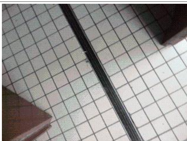
Prélèvement - P9 : CPAM / RDC / ENT.FOURNI - Joint de dilatation- (Absence d'amiante)
