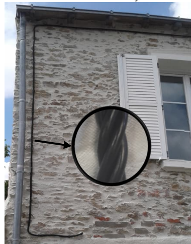
Réseau fils isolés façade BT
