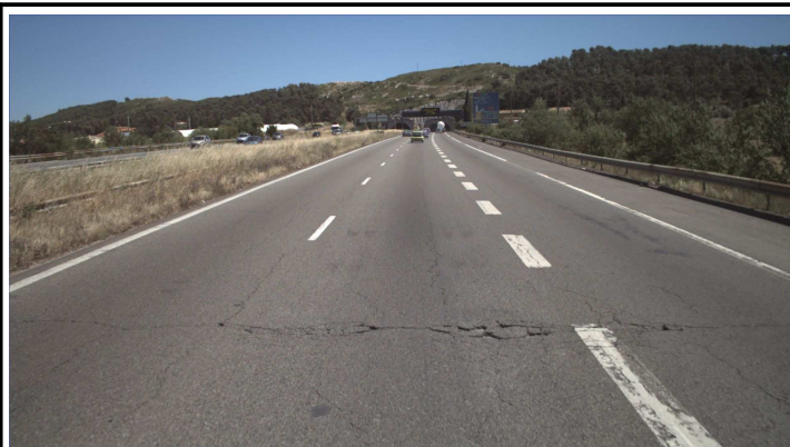
Illustration 6: PR 264+430 sens plus - FT ramifiée, ouverte et affaissée
