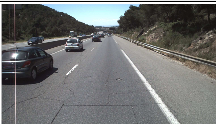
Illustration 10: PR 270+314 sens moins - faïençage grave non spécifique aux bandes de roulement (avec départs de matériaux et ramifications )
