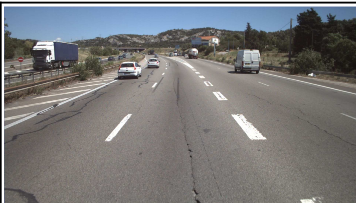
Illustration 11: PR 265+1080 sens plus – FL ouverte et affaissée
