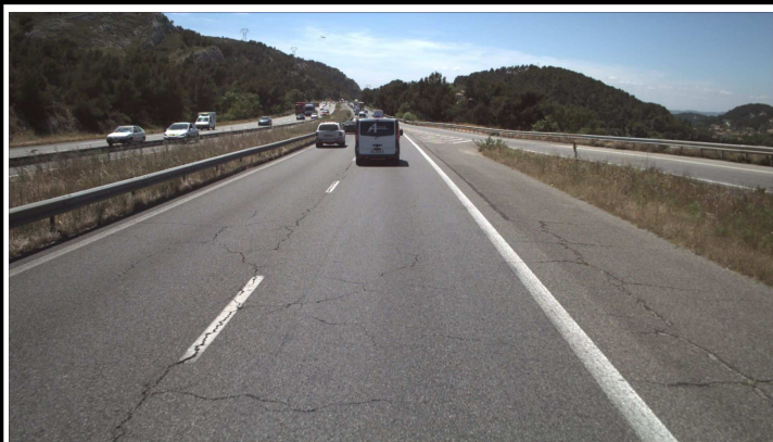
Illustration 15: PR 268+698 sens moins fissuration sur les deux voies
