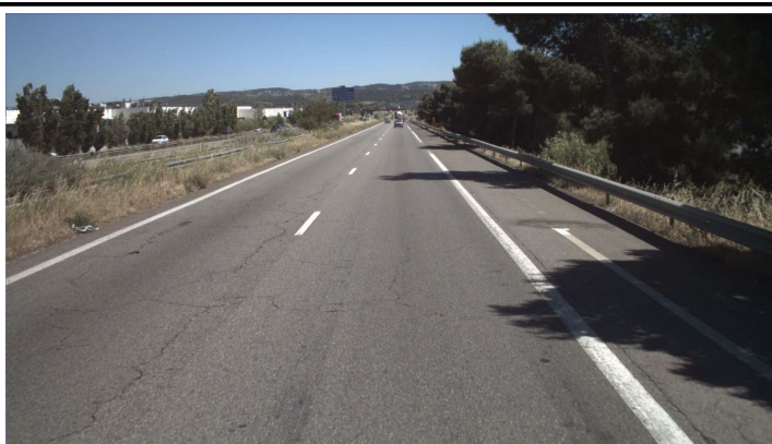
Illustration 14: PR 261+821 sens plus – Faïencage non spécifique bandes de roulement en voie rapide
