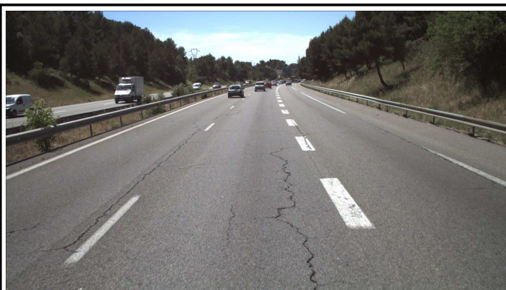
Illustration 8: PR 267+733 sens moins - fissure longitudinale spécifique aux bandes de roulement
