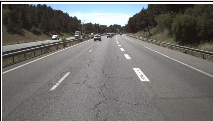
Illustration 9: PR 267+748 sens moins - faïençage significatif non spécifique aux bandes de roulement
