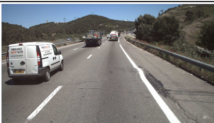
Illustration 12: PR 269+410 sens plus - FT ramifiée, ouverte et affaissée
