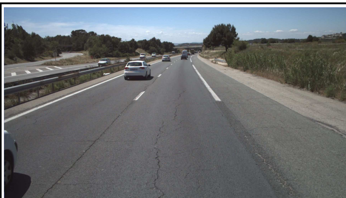
Illustration 7: PR 267+173 sens moins - fissure longitudinale non spécifique aux bandes de roulement
