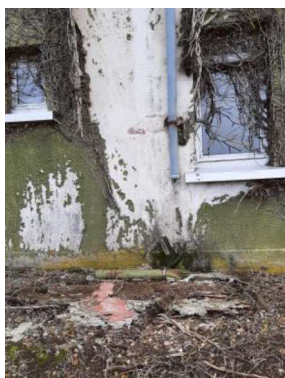
Discontinuité des descentes EP avec le réseau.
