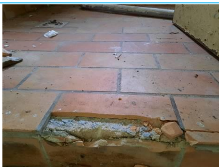
Matériaux : ZPSO-006 Prélèvement : P009 Description : Colle GRISE de carrelage sol Localisation : Rez de chaussée - sanitaire chambre 6 Résultat : Absence d'amiante
