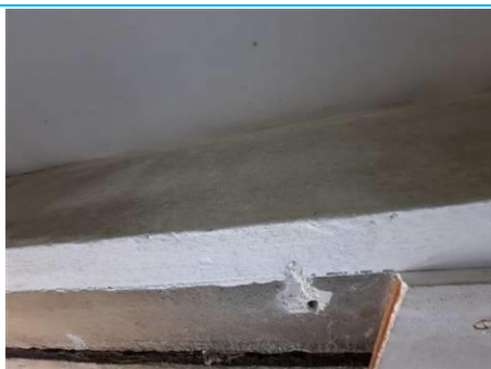
Matériaux : ZPSO-043 Prélèvement : P069 Description : Enduit plâtre gros poteau plafond Localisation : 1er étage - chambre 110 Résultat : Absence d'amiante
