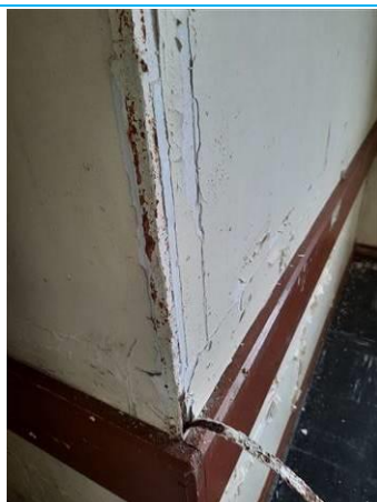
Matériaux : ZPSO-019 Prélèvement : P032 Description : Enduit+peinture+calicot Localisation : Rez de chaussée - chambre 9 Résultat : Absence d'amiante
