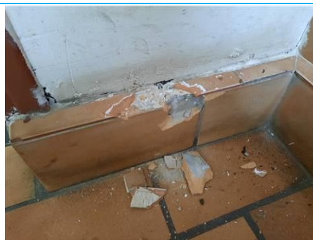
Matériaux : ZPSO-011 Prélèvement : P020 Description : Colle de plinthe carrelée Localisation : Rez de chaussée - sanitaire chambre 15 Résultat : Absence d'amiante
