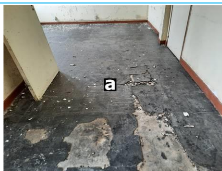
Matériaux : ZPSO-002 Prélèvement : P002 Description : Dalle de sol noire+colle+rag Localisation : Rez de chaussée - chambre 9 Résultat : Présence d'amiante
