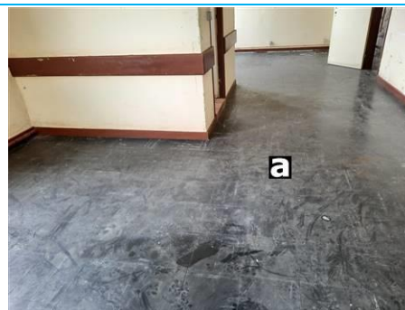
Matériaux : ZPSO-003 Prélèvement : P004 Description : Dalle de sol noire+colle+rag Localisation : Rez de chaussée - chambre 15 Résultat : Présence d'amiante
