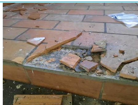
Matériaux : ZPSO-006 Prélèvement : P010 Description : Colle GRISE de carrelage sol Localisation : Rez de chaussée - sanitaire chambre 4 Résultat : Absence d'amiante
