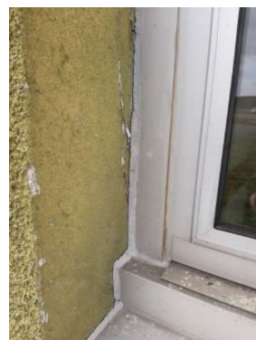
Joint d'étanchéité défectueux en périphérie du dormant avec la maçonnerie.
