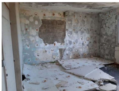
Doublage intérieur effondré sous l'effet de l'humidité.
