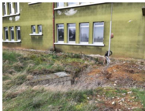
Canalisations électriques non protégées en façades.
