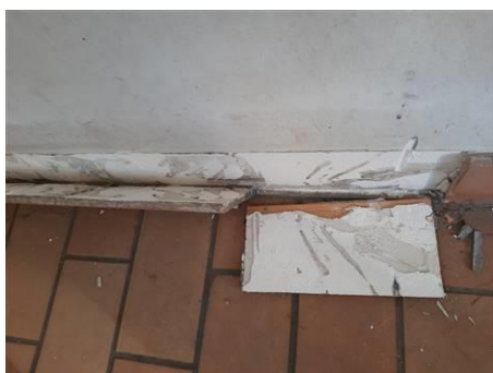
Matériaux : ZPSO-054 Prélèvement : P082 Description : Colle de plinthe carrelée Localisation : 1er étage - sanitaire chambre 101 Résultat : Absence d'amiante
