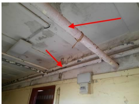
Photo n° PhPb005 Localisation : Rez de chaussée - ensemble des chambres UD : ensemble des canalisations (mesure 2) Type de dégradation : NC - Substrat : métal - Revêtement : peinture - Mesure : 0,34
