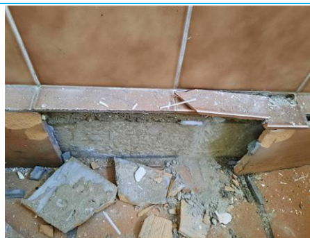
Matériaux : ZPSO-053 Prélèvement : P081 Description : Colle de plinthe carrelée Localisation : 1er étage - sanitaire chambre 116 Résultat : Absence d'amiante
