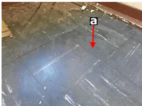
Matériaux : ZPSO-047 Prélèvement : P074 Description : Dalle de sol NOIRE+colle+ragréage Localisation : 1er étage - chambre 110 Résultat : Présence d'amiante
