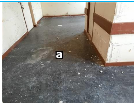
Matériaux : ZPSO-001 Prélèvement : P001 Description : Dalle de sol noire+colle+rag Localisation : Rez de chaussée - chambre 6 Résultat : Présence d'amiante
