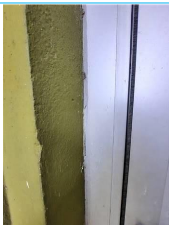
Matériaux : ZPSO-067 Prélèvement : P099 Description : Joint d'étanchéité entre bâti de porte et maçonnerie Résultat : Absence d'amiante
