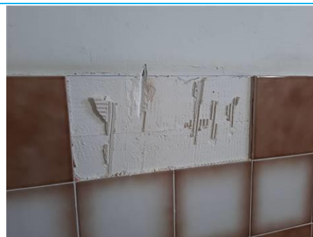
Matériaux : ZPSO-061 Prélèvement : P091 Description : Colle de faïence Localisation : 1er étage - sanitaire chambre 116 Résultat : Absence d'amiante
