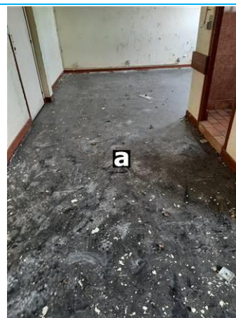
Matériaux : ZPSO-001 Prélèvement : P006 Description : Dalle de sol noire+colle+rag Localisation : Rez de chaussée - chambre 4 Résultat : Présence d'amiante
