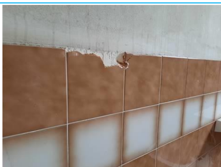
Matériaux : ZPSO-012 Prélèvement : P021 Description : Colle de faïence Localisation : Rez de chaussée - sanitaire chambre 6 Résultat : Absence d'amiante
