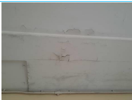
Matériaux : ZPSO-028 Prélèvement : P050 Description : Enduit+peinture plafond Localisation : Rez de chaussée - chambre 4 Résultat : Absence d'amiante
