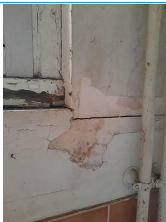
Matériaux : ZPSO-024 Prélèvement : P042 Description : Enduit+peinture+calicot PH Localisation : Rez de chaussée - sanitaire chambre 6 Résultat : Absence d'amiante
