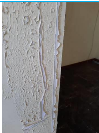
Matériaux : ZPSO-057 Prélèvement : P086 Description : Enduit+peinture+calicot mur Localisation : 1er étage - chambre 101 Résultat : Absence d'amiante
