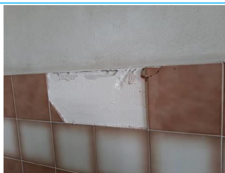
Matériaux : ZPSO-012 Prélèvement : P022 Description : Colle de faïence Localisation : Rez de chaussée - sanitaire chambre 4 Résultat : Absence d'amiante
