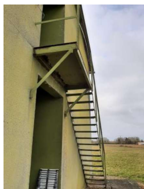
Vue de l'escalier à l'air libre – Etat de corrosion avancé de l'ossature métallique.
