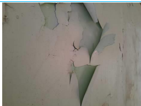
Matériaux : ZPSO-060 Prélèvement : P090 Description : Enduit+peinture mur Localisation : 1er étage - circulation 2 Résultat : Absence d'amiante
