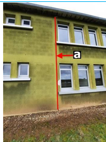
Matériaux : ZPSO-065 Prélèvement : P097 Description : Joint de dilatation Localisation : Extérieur - Façade EST Résultat : Présence d'amiante
