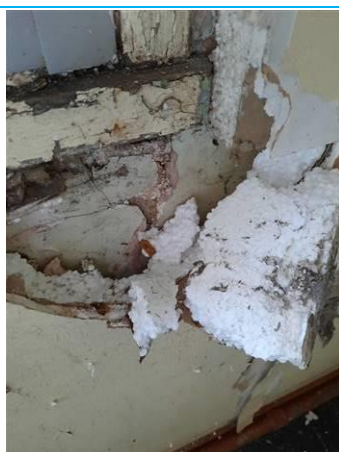
Matériaux : ZPSO-021 Prélèvement : P036 Description : Plot de colle fixant les cloisons Résultat : Absence d'amiante
