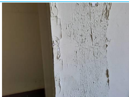
Matériaux : ZPSO-058 Prélèvement : P088 Description : Enduit+peinture+calicot mur Localisation : 1er étage - chambre 110 Résultat : Absence d'amiante
