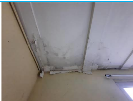
Matériaux : ZPSO-030 Prélèvement : P054 Description : Enduit+peinture plafond Localisation : Rez de chaussée - chambre 15 Résultat : Absence d'amiante
