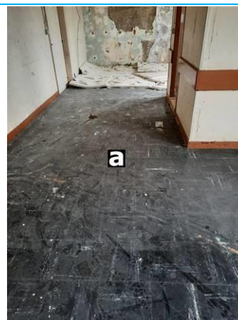
Matériaux : ZPSO-003 Prélèvement : P003 Description : Dalle de sol noire+colle+rag Localisation : Rez de chaussée - chambre 13 Résultat : Présence d'amiante
