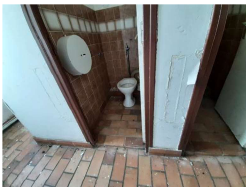
Présence de ressaut au droit seuils d'accès aux cabinets d'aisance.
