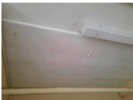
Matériaux : ZPSO-029 Prélèvement : P052 Description : Enduit+peinture plafond Localisation : Rez de chaussée - chambre 1 Résultat : Absence d'amiante
