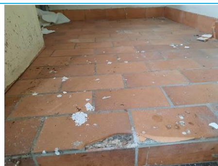
Matériaux : ZPSO-007 Prélèvement : P012 Description : Colle GRISE de carrelage sol Localisation : Rez de chaussée - sanitaire chambre 1 Résultat : Absence d'amiante
