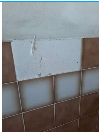
Matériaux : ZPSO-063 Prélèvement : P093 Description : Colle BLANCHE de faïence Localisation : 1er étage - sanitaire chambre 107 Résultat : Absence d'amiante
