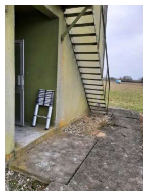
Entrée du bâtiment, Présence de marche, cheminements discontinus et effet pianotage du revêtement de sol.
