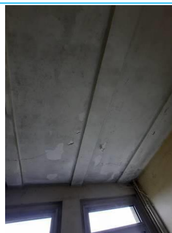
Matériaux : ZPSO-030 Prélèvement : P053 Description : Enduit+peinture plafond Localisation : Rez de chaussée - chambre 13 Résultat : Absence d'amiante
