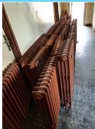
Photo n° PhPb006 Localisation : Rez de chaussée - circulation 1 UD : Ensemble des radiateurs (Radiateurs) (mesure 1) Type de dégradation : NC - Substrat : Métal - Revêtement : Peinture - Mesure : 0,9
