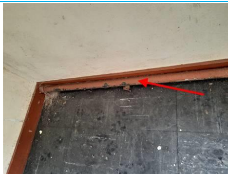
Photo n° PhPb004 Localisation : Rez de chaussée - ensemble des chambres UD : ensemble des canalisations (mesure 1) Type de dégradation : NC - Substrat : métal - Revêtement : peinture - Mesure : 0,33
