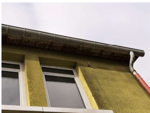
Débord de toiture fortement corrodé.
