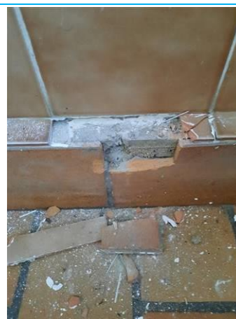
Matériaux : ZPSO-055 Prélèvement : P083 Description : Colle de plinthe carrelée Localisation : 1er étage - sanitaire chambre 107 Résultat : Absence d'amiante
