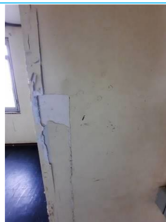
Matériaux : ZPSO-020 Prélèvement : P035 Description : Enduit+peinture+calicot Localisation : Rez de chaussée - chambre 15 Résultat : Absence d'amiante
