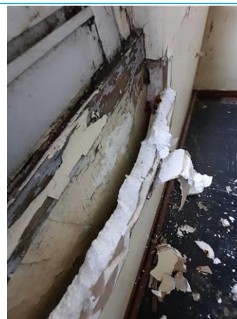
Matériaux : ZPSO-023 Prélèvement : P041 Description : Plot de colle fixant les cloisons Résultat : Absence d'amiante
