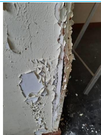
Matériaux : ZPSO-019 Prélèvement : P033 Description : Enduit+peinture+calicot Localisation : Rez de chaussée - chambre 1 Résultat : Absence d'amiante
