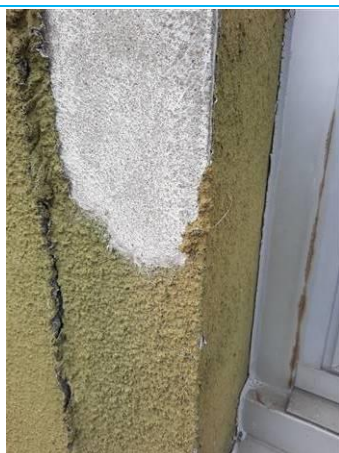
Matériaux : ZPSO-064 Prélèvement : P095 Description : Enduit extérieur+peinture Localisation : Extérieur - Façade EST Résultat : Absence d'amiante
