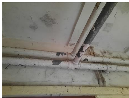
Matériaux : ZPSO-031 Prélèvement : P055 Description : Peinture sur canalisation Résultat : Absence d'amiante
