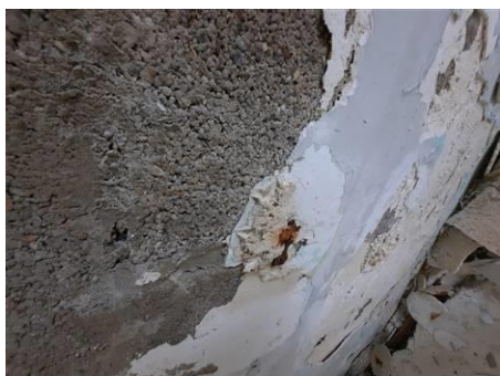
Matériaux : ZPSO-023 Prélèvement : P040 Description : Plot de colle fixant les cloisons Résultat : Absence d'amiante
