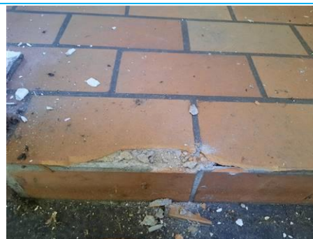
Matériaux : ZPSO-051 Prélèvement : P079 Description : Colle de carrelage Localisation : 1er étage - sanitaire chambre 110 Résultat : Absence d'amiante
