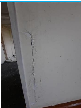
Matériaux : ZPSO-020 Prélèvement : P034 Description : Enduit+peinture+calicot Localisation : Rez de chaussée - chambre 13 Résultat : Absence d'amiante
