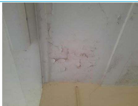
Matériaux : ZPSO-029 Prélèvement : P051 Description : Enduit+peinture plafond Localisation : Rez de chaussée - chambre 9 Résultat : Absence d'amiante
