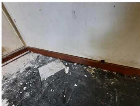
Photo n° PhPb001 Localisation : Rez de chaussée - Ensemble des chambres UD : Ensemble des plinthes (mesure 1) Type de dégradation : NC - Substrat : bois - Revêtement : peinture - Mesure : 0,8
