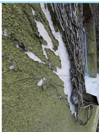
Matériaux : ZPSO-064 Prélèvement : P096 Description : Enduit extérieur+peinture Localisation : Extérieur - Façade OUEST Résultat : Absence d'amiante
