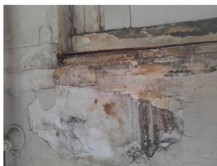
Matériaux : ZPSO-024 Prélèvement : P043 Description : Enduit+peinture+calicot PH Localisation : Rez de chaussée - sanitaire chambre 4 Résultat : Absence d'amiante
