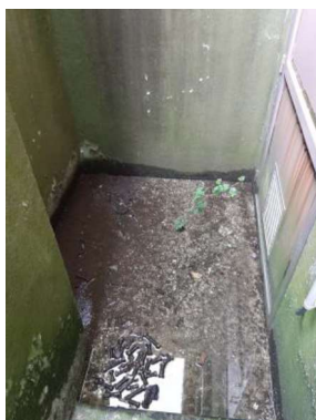
Absence de dispositif d'évacuation des eaux au sol de la cour anglaise – Accès sous-station.
