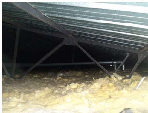
Charpente métallique corrodée en surface. Bac acier de couverture simple peau.
