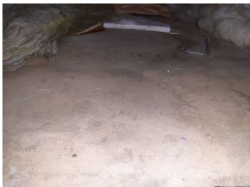
Revêtement de faux-plafond sous les combles (une peau de BA13)
