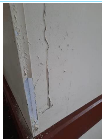
Matériaux : ZPSO-018 Prélèvement : P031 Description : Enduit+peinture+calicot Localisation : Rez de chaussée - chambre 4 Résultat : Absence d'amiante
