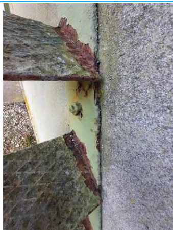
Matériaux : ZPSO-066 Prélèvement : P098 Description : Peinture escalier Résultat : Absence d'amiante
