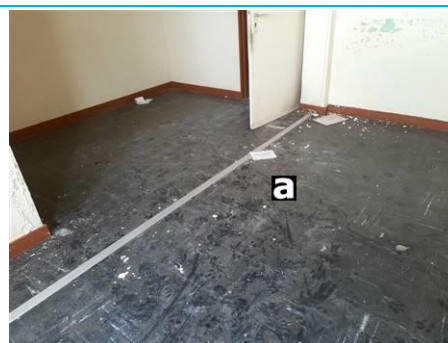
Matériaux : ZPSO-002 Prélèvement : P005 Description : Dalle de sol noire+colle+rag Localisation : Rez de chaussée - chambre 1 Résultat : Présence d'amiante
