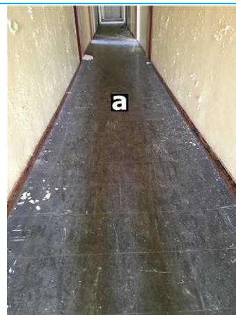
Matériaux : ZPSO-048 Prélèvement : P075 Description : Dalle de sol NOIRE+colle+ragréage Localisation : 1er étage - circulation 1 Résultat : Présence d'amiante
