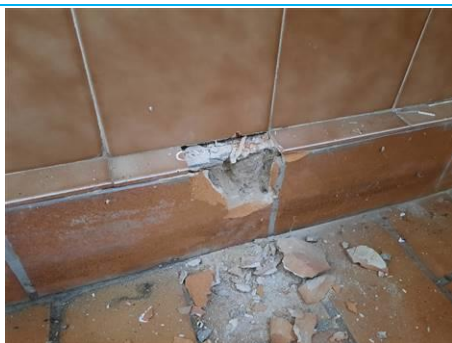
Matériaux : ZPSO-011 Prélèvement : P019 Description : Colle de plinthe carrelée Localisation : Rez de chaussée - sanitaire chambre 13 Résultat : Absence d'amiante
