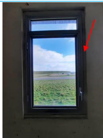
Photo n° Ph Localisation : Rez de chaussée - Ensemble des chambres UD : Fenêtre intérieure (Ensemble des fenêtres) (Huisserie ancien dormant) Type de dégradation : NC - Substrat : Bois - Revêtement : Peinture - Mesure : 0,16
