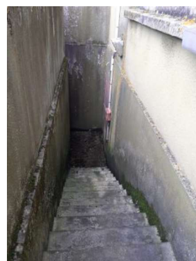
Absence de main-courante de l'escalier desservant la sous-station. Nez-de-marche non anti dérapant.
