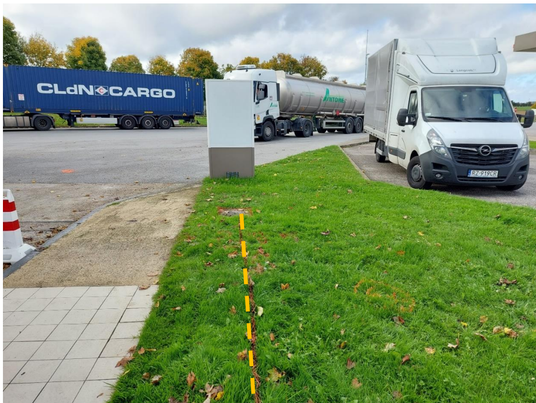
Traçage d'une conduite de carburant vers la zone de distribution des PL
