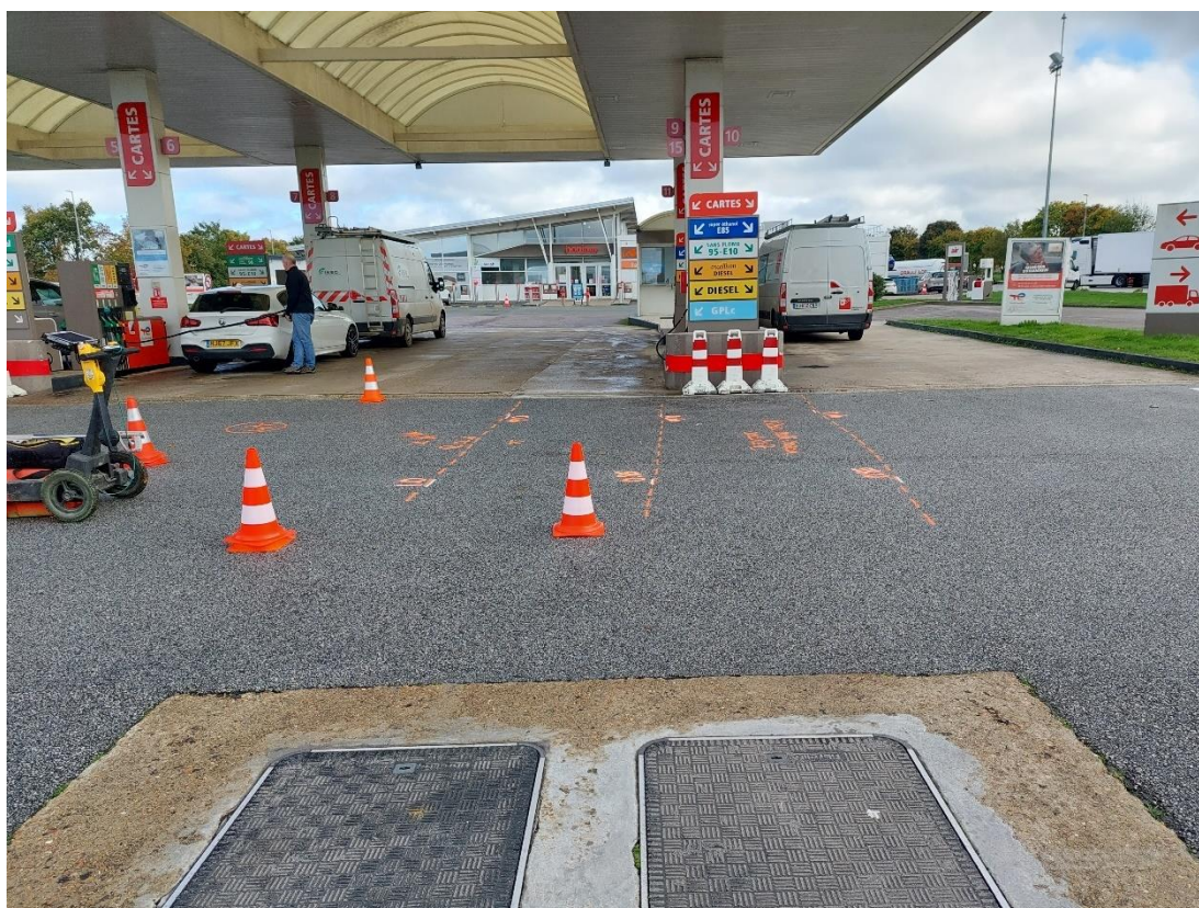
Tracage des conduites de carburants de manifold vers la zone de distribution des VL
