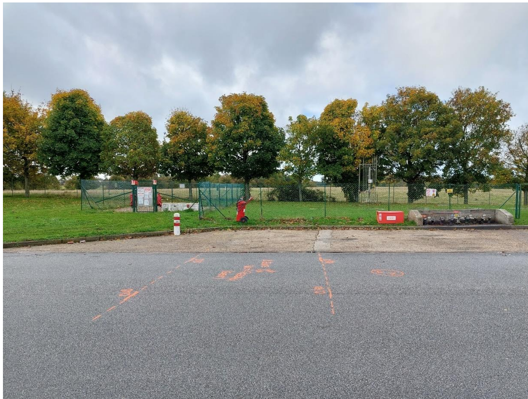
Tracage des conduites de carburants de parc à cuves vers les 2 manifolds
