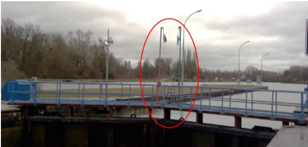
Figure 4 - repères visuels sur écluse : perches en bout de porte
