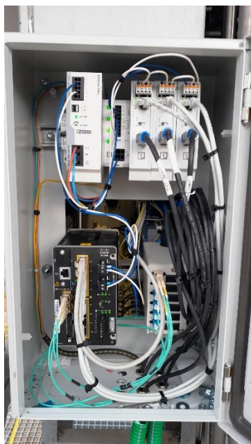
Figure 39-exemple d'intégration du switch de terrain sur coffret de tête neuf
