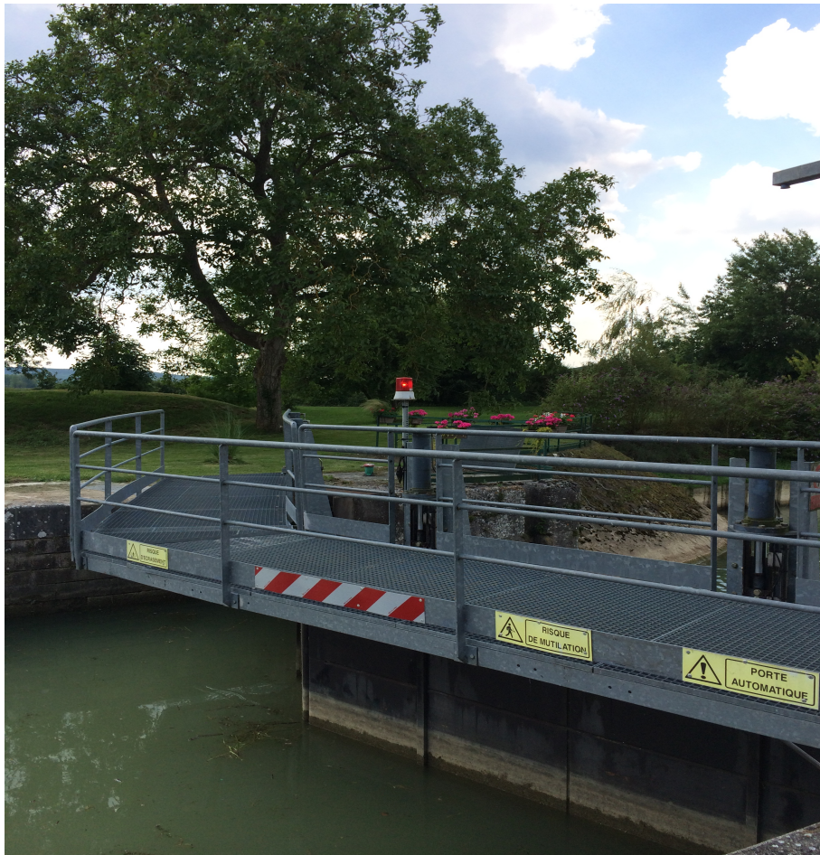
Implantation d'un feu de sas visible des 2 cotés
