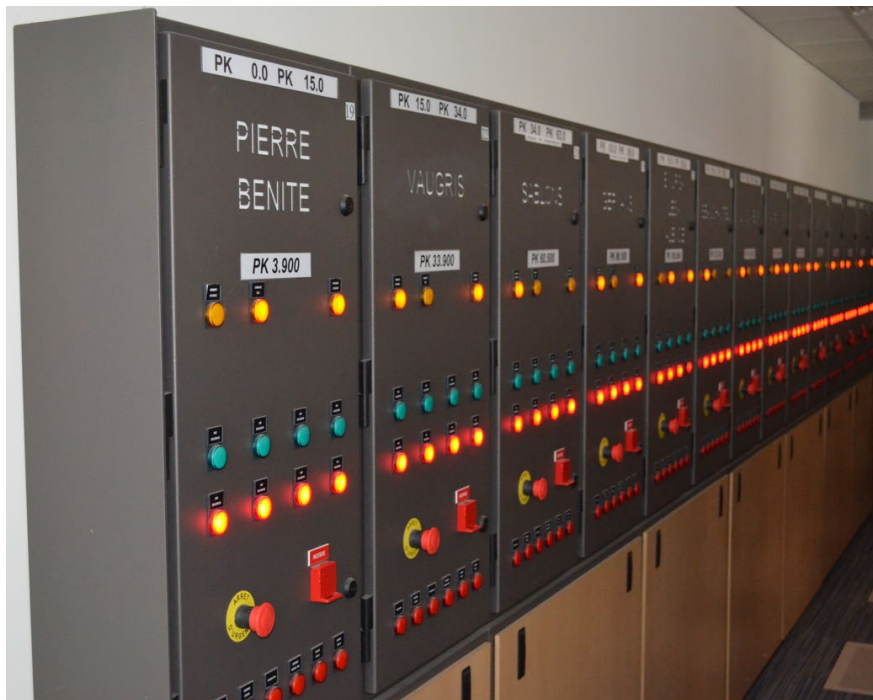
Figure 15 - Mur d'arrêts d'urgence du centre de gestion de la navigation de la CNR
