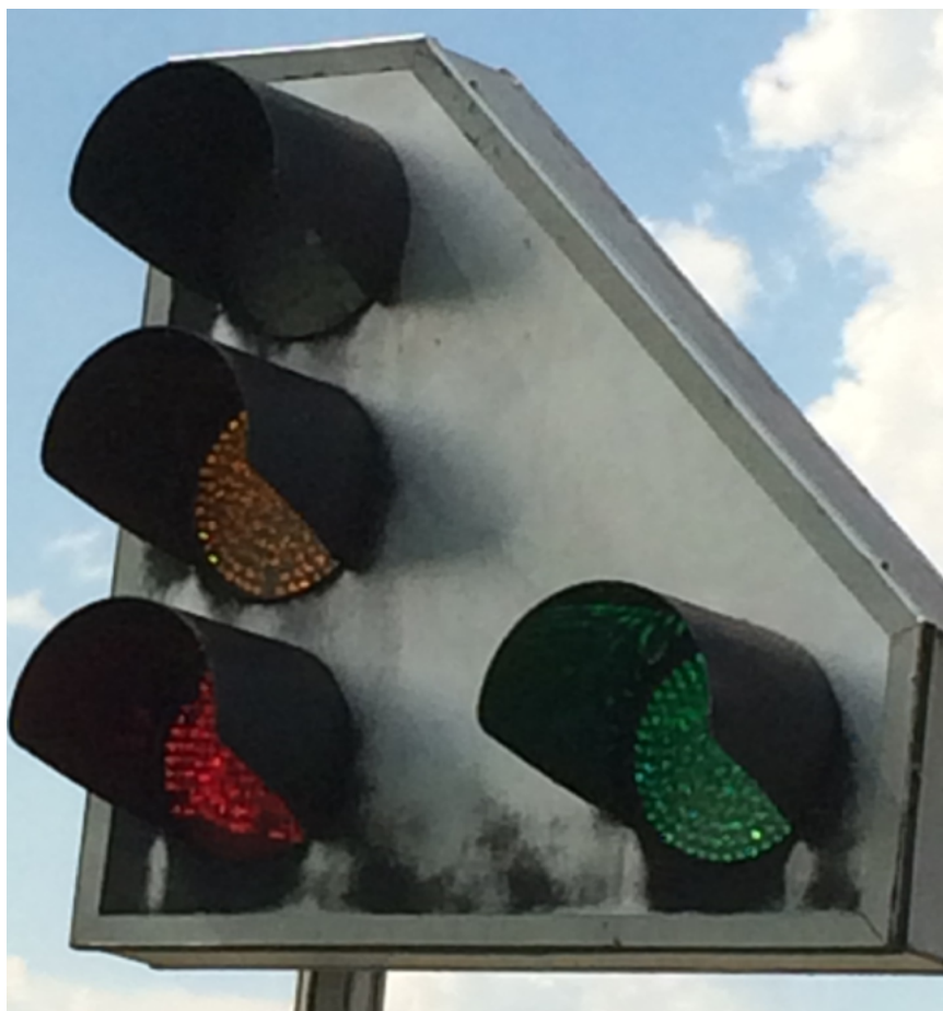
Panneau de feux intégrant une optique orange
