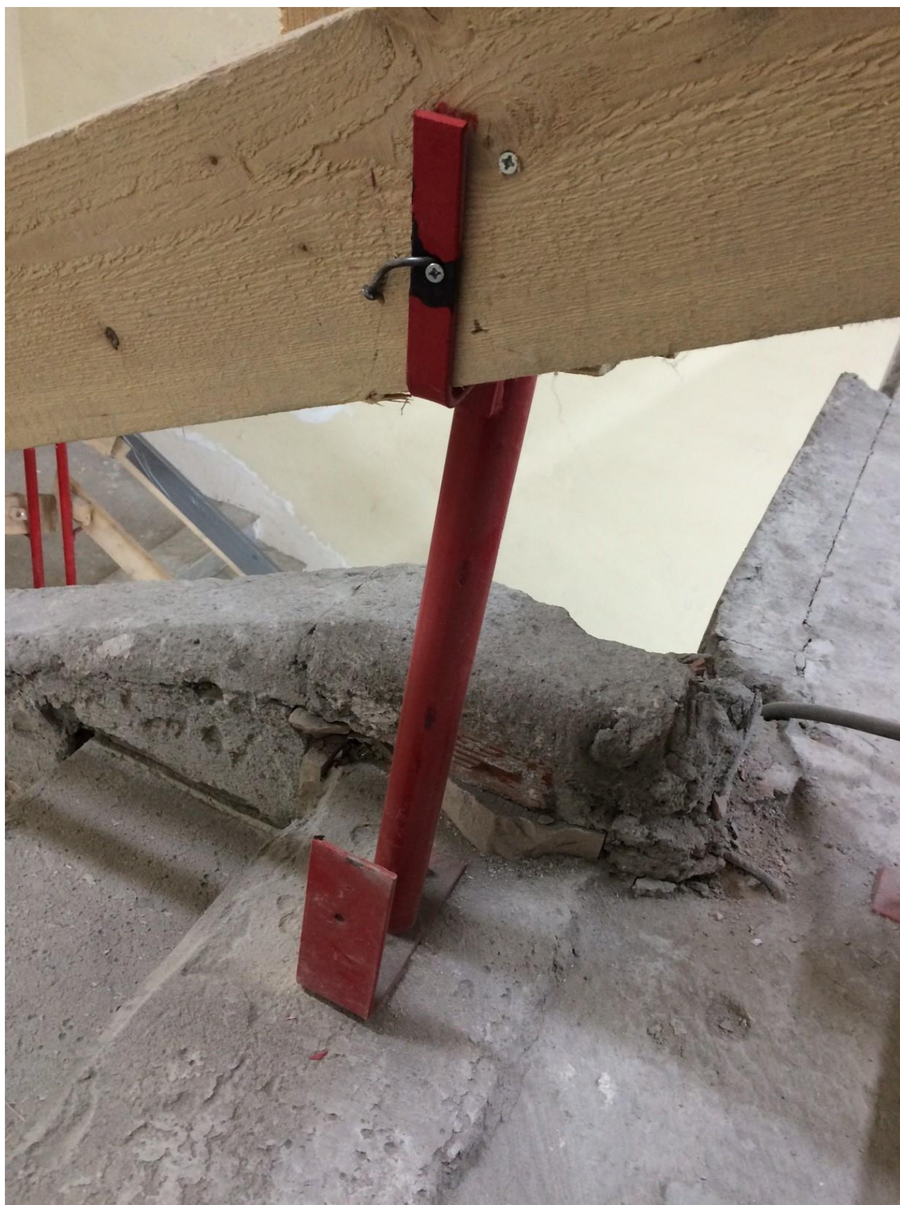
Escalier Garde-corps provisoire
