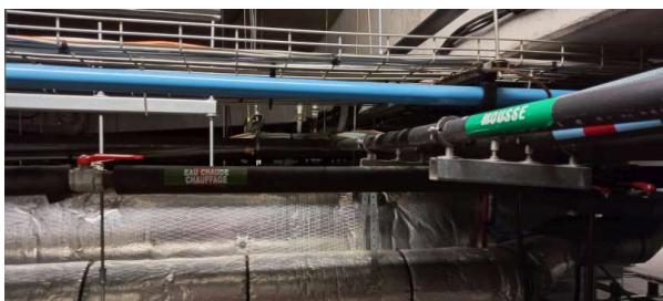
Déclaré - : Niveau 00 / Combles - Calorifuge coquille- (Absence d'amiante)
