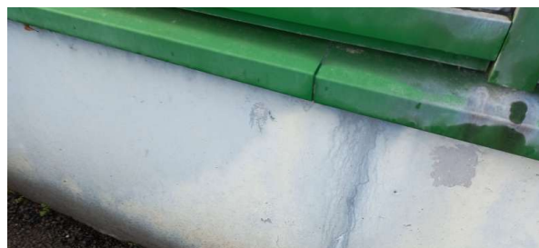
Prélèvement - P1 : Façades - Enduit- (Absence d'amiante)
