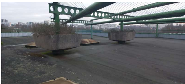
Prélèvement - P7 : Toiture - Lé bitumineux- (Absence d'amiante)
