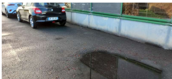
Prélèvement - P2 : Extérieur - Enrobé bitumineux- (Absence d'amiante)
