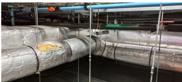
Déclaré - : Niveau 00 / Combles - Enveloppe de calorifugeage- (Absence d'amiante)
