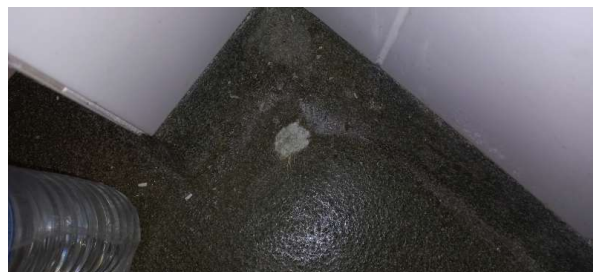
Prélèvement - P3 : Niveau 1 / Cave à vin 125 - Sol coulé- (Absence d'amiante)
