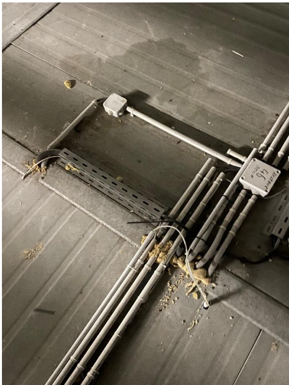
PRINCIPE DE CHEMINEMENT EN COMBLES TECHNIQUES
