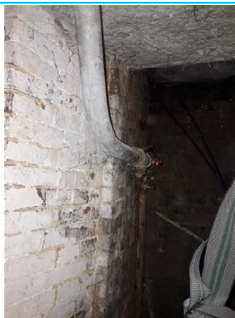
Photo n° PhPb001 Localisation : GSS11 UD : Canalisations arrivées d'eau (mesure 1)
