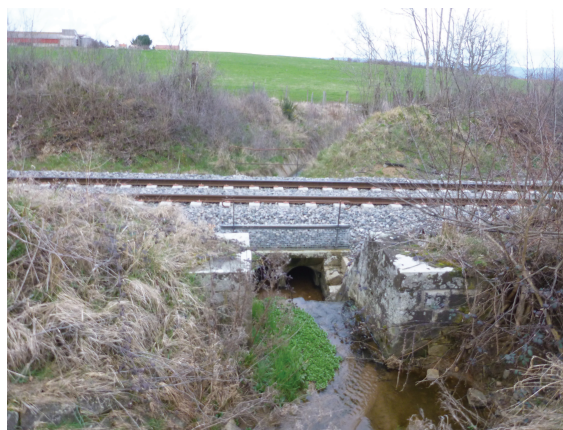
Illustration 12 : Passage de l'écoulement temporaire sous un ouvrage SNCF (au droit du profil P51)
